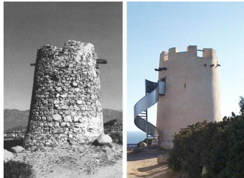
Fig. 3- The Su Fenegu Tower
