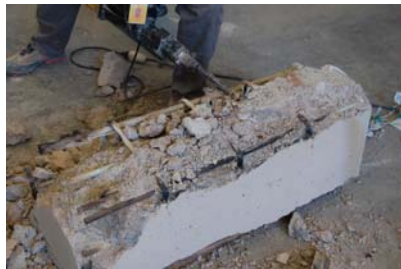
Figura 149. Recuperación de armaduras Pilar 2
