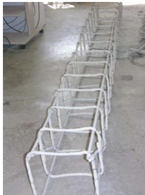
Figura 101. Armadura del pilar
