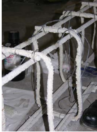
Figura 82. Detalle de las armaduras de las vigas y disposición de las galgas
