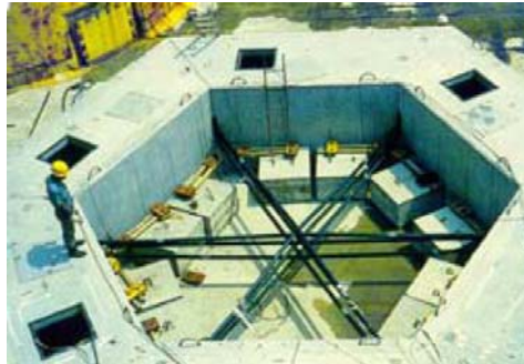
Figura 2. Elementos Leadline (CFRP) en las diagonales de una estructura flotante marina.
