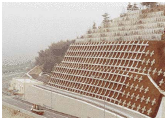
Figura 6. Sistemas de anclaje/contención de tierras
