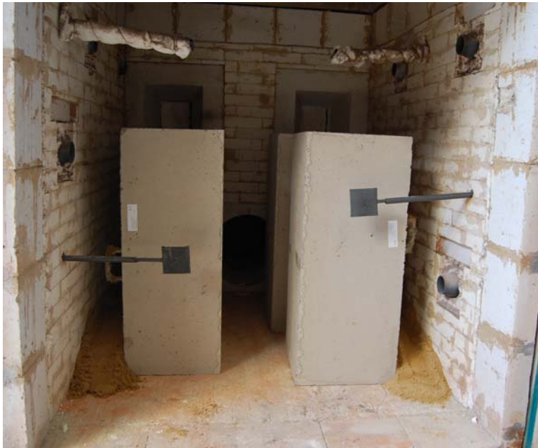
Figura 138. Montaje de los pilares en el horno
