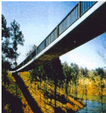
Figura 5. Tableros de puentes
