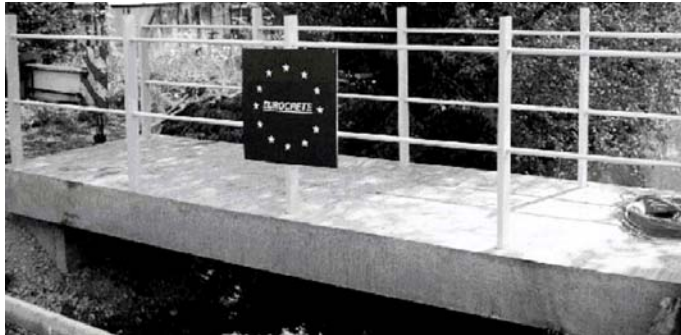
Figura 7. Puente totalmente armado con redondos de FRP. EUROCRETE Project
