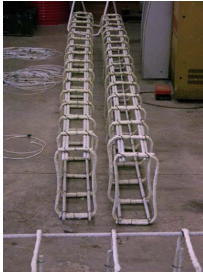
Figura 80. Detalle de las armaduras de las vigas
