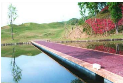
Figura 3. Elementos FIBRA (AFRP) en tirantes de puentes flotantes.
