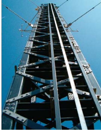
Figura 4. Sistemas estructurales transparentes a las ondas electromagnéticas
