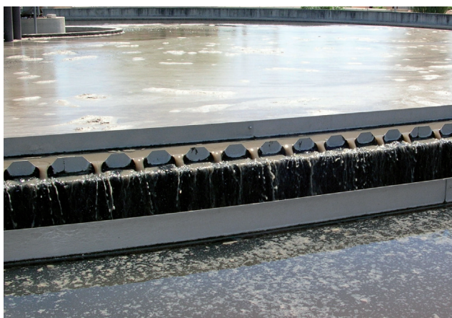
FIGURA 1. Problemas de separación del fango activo: episodio de bulking (izquierda) y episodio de foaming (derecha).
