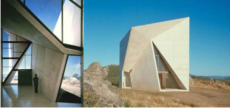
Fig. 4 - S.M.A.O. Arquitectos, Capilla, Valleacero 1997-2000.
