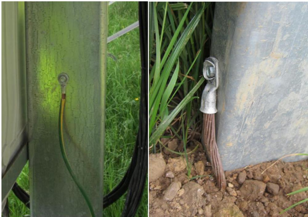
*Figura 23: Cable puesta a tierra (Fuente: Proyecto actual en Inglaterra)*
