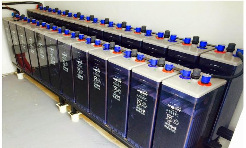
Se define la capacidad de una batería como la cantidad de electricidad que puede obtenerse durante una descarga completa de la batería plenamente llena. Esta capacidad se mide en amperios/hora (Ah), para un determinado tiempo de descarga.
