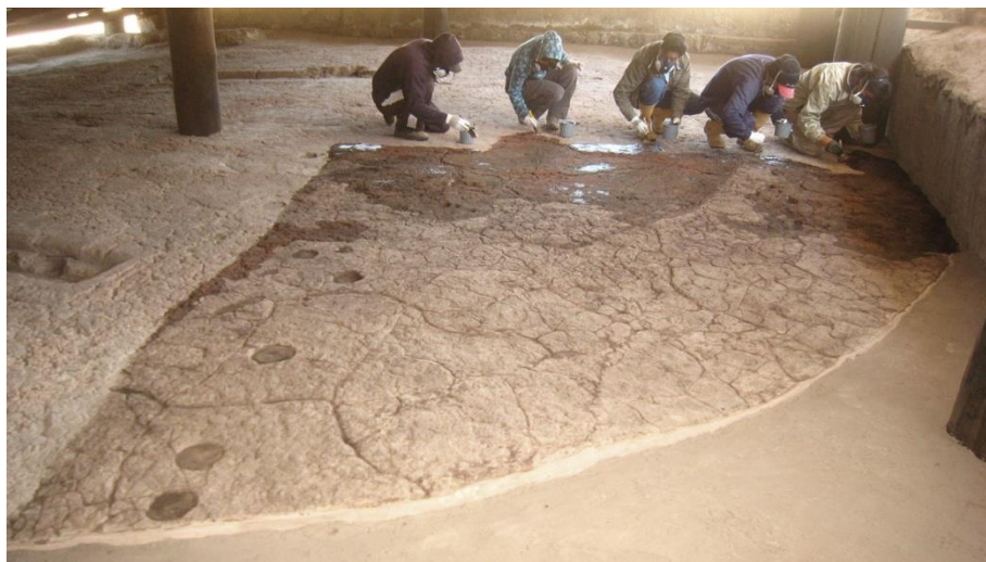
Figura 4 - Proceso de consolidación y protección final de plataforma cerámica superior.
