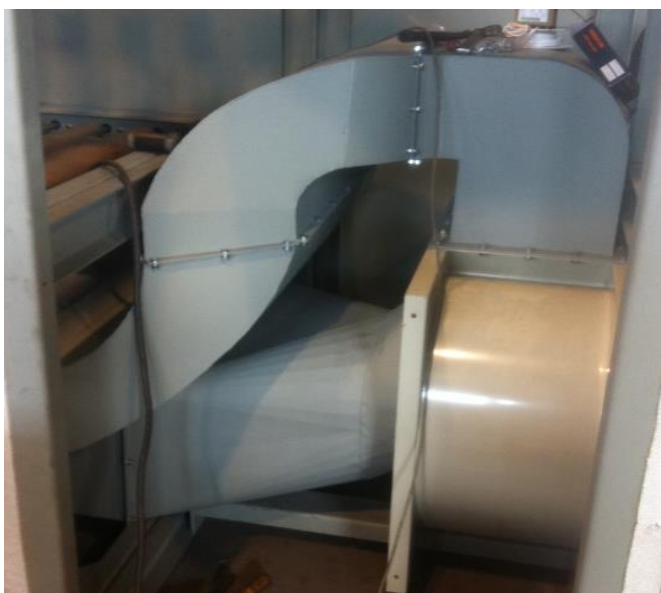
Fig. 20 Conjunto ventilador y unión tobera.
