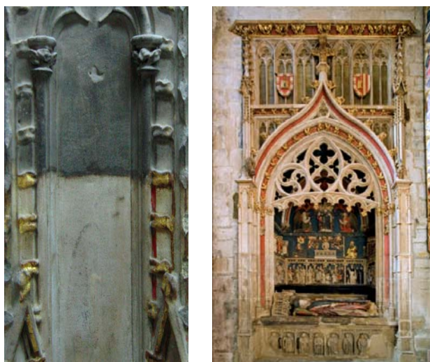
Fig.1. (a. y b.) a. Gruesa capa de suciedad adherida a la superficie de la jamba del Sepulcro de Villaespesa . b. Sepulcro del Canciller Villaespesa y su esposa tras su restauración. © Gobierno de Navarra.
