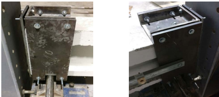
Figura 6. Chapas metálicas para o confinamento dos apoios
