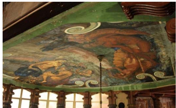
Figura 9. Concrecions salines de la pintura mural.
