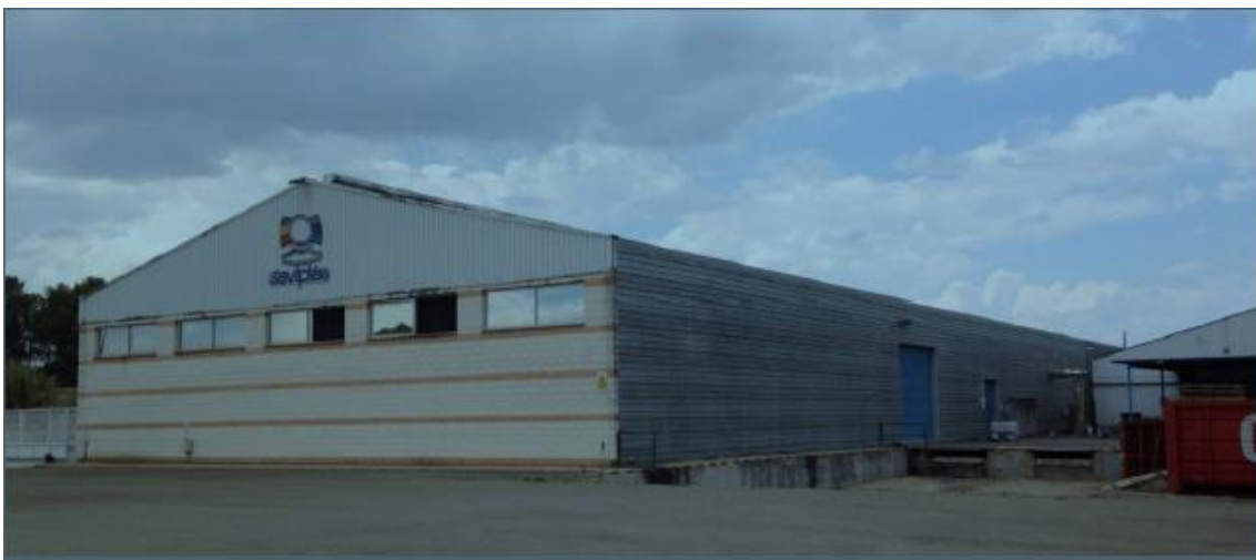
Il·lustració 8. Exterior instal·lacions Gaviplas S.L
