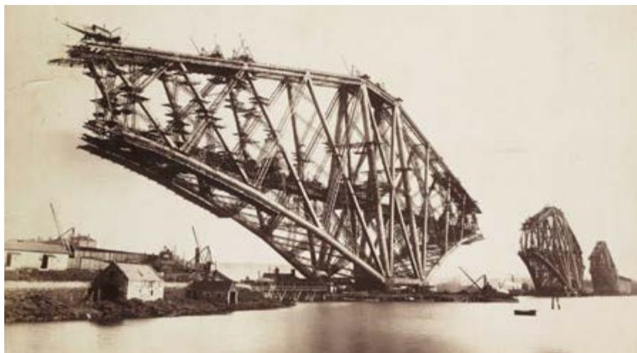
Figura 1: Construcción del Puente Forth Fuente: The Forth Bridge (1890)
