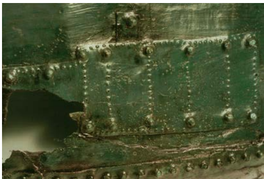
Figura 2. Detalle de una de las reparaciones de época mediante una chapa unida con remaches.
