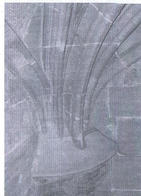
Figura 05. Arriba, imagen de la bóveda de la Capilla de la Lonja. Abajo, uno de los arranques donde puede verse el perfil de los formeros junto a diagonales y terceletes. (Foto: E. Capilla. 31-10-2004)
