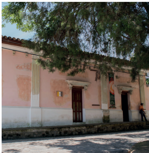
Figura 6.9. Casa Galeano. Fachada norte. Vista de la entrada actual al Centro de Interpretación, 2016. Fte: Elaboración propia
