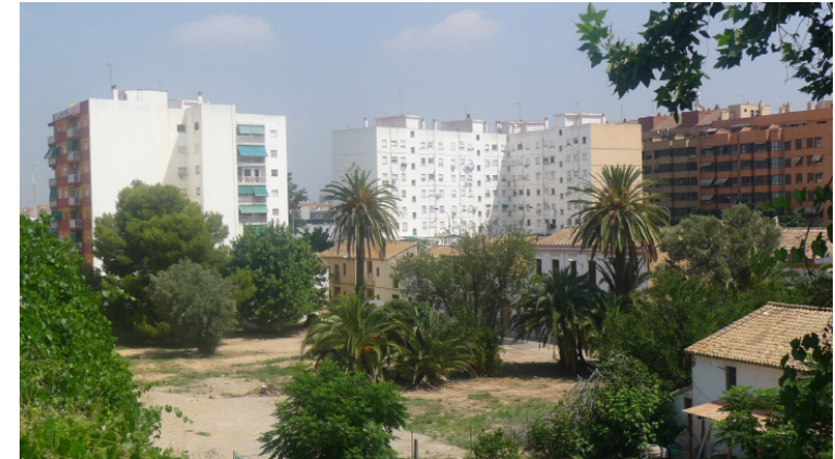
(4) Viviendas de la Calle Pau
