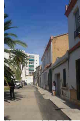
(2) Viviendas de la Calle Pau
