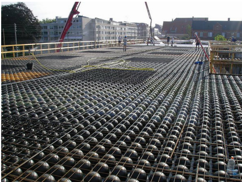
Sistema estructural Bubble Deck.
