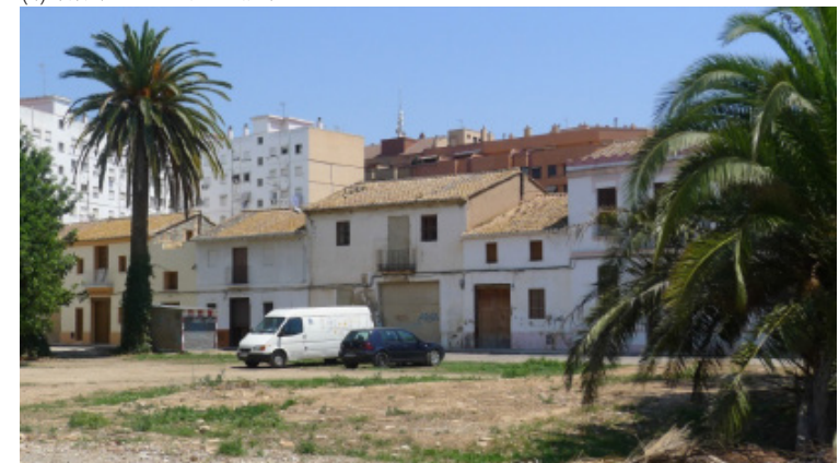
(6) Viviendas de la Calle Pau
