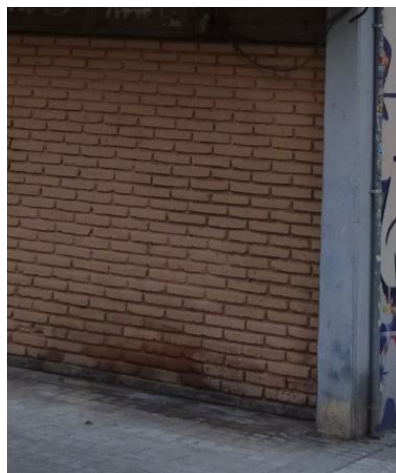
Imagen 4.11: Arranque del muro de cara vista donde se observan las deposiciones de los animales.
