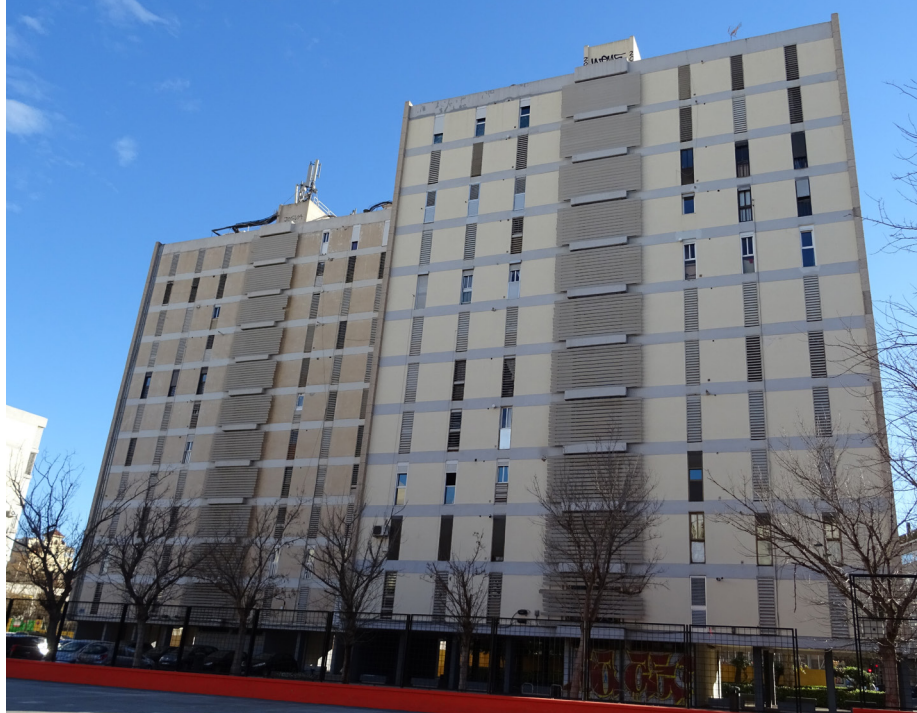
Imagen 3.30: Torres de XII alturas C12-4, donde se observan los cantos de forjado que albergan las ventanas de los dormitorios y la zona de servidumbre.
