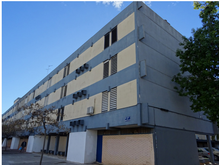
Imagen 3.32: Edificio de 4 alturas donde se aprecian las bandas horizontales.
