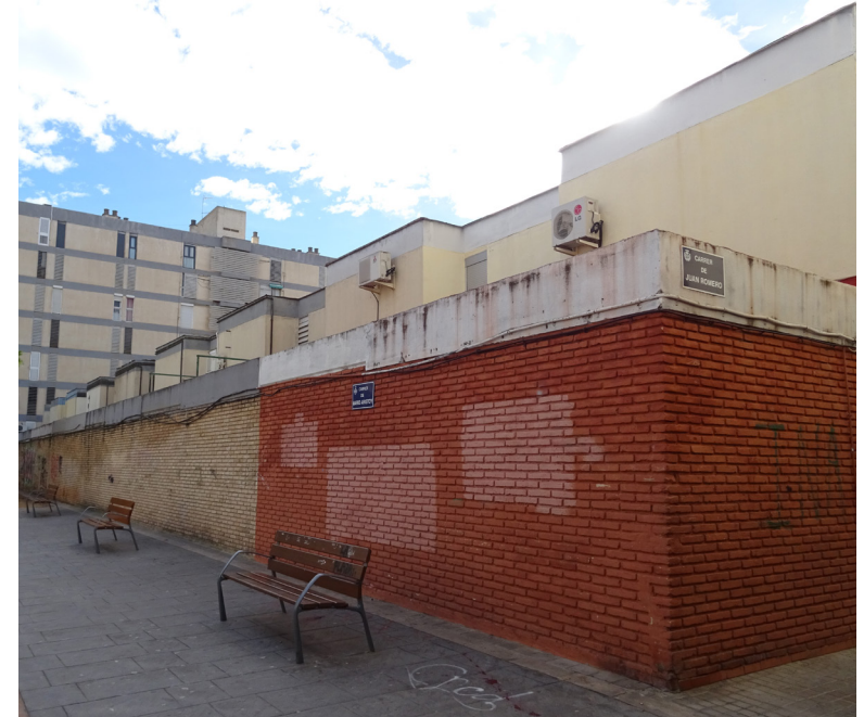
Imagen 3.27: Viviendas A2-4 en las que se observa la incorporación del ladrillo cara vista para las fachadas principales en planta baja.
