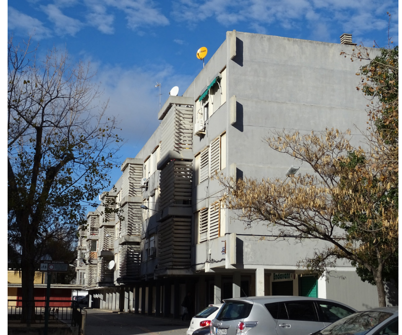
Imagen 3.25: Bloque A4-3 en el que se ven los núcleos verticales sobresaliendo del plano de fachada.
