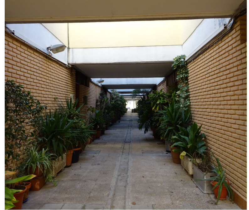
Imagen 3.29: Calle semicubiertas de las viviendas unifamiliares B2-3, en el que se percibe la iluminación tenue y la privacidad de los pozos de luz.
