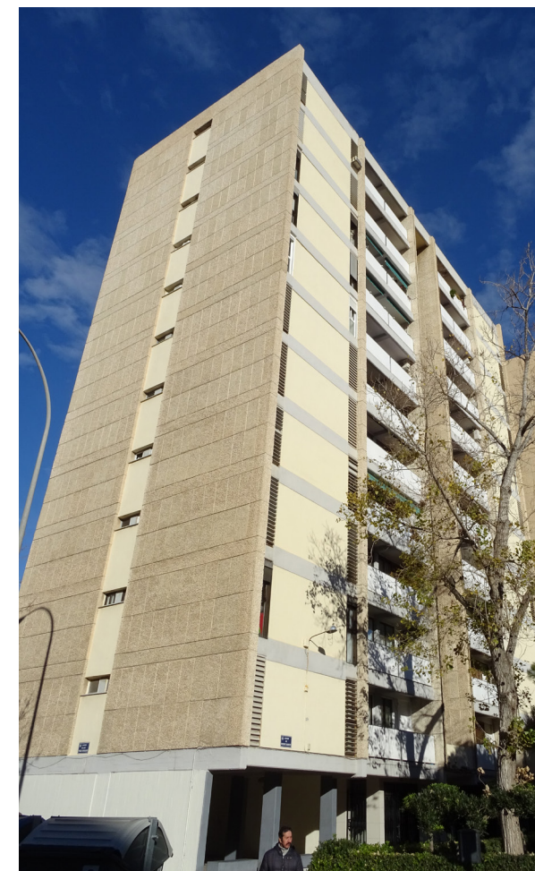
Imagen 3.40: Fotografía de una de las torres en la que se observa la fachada principal y el testero lateral.
