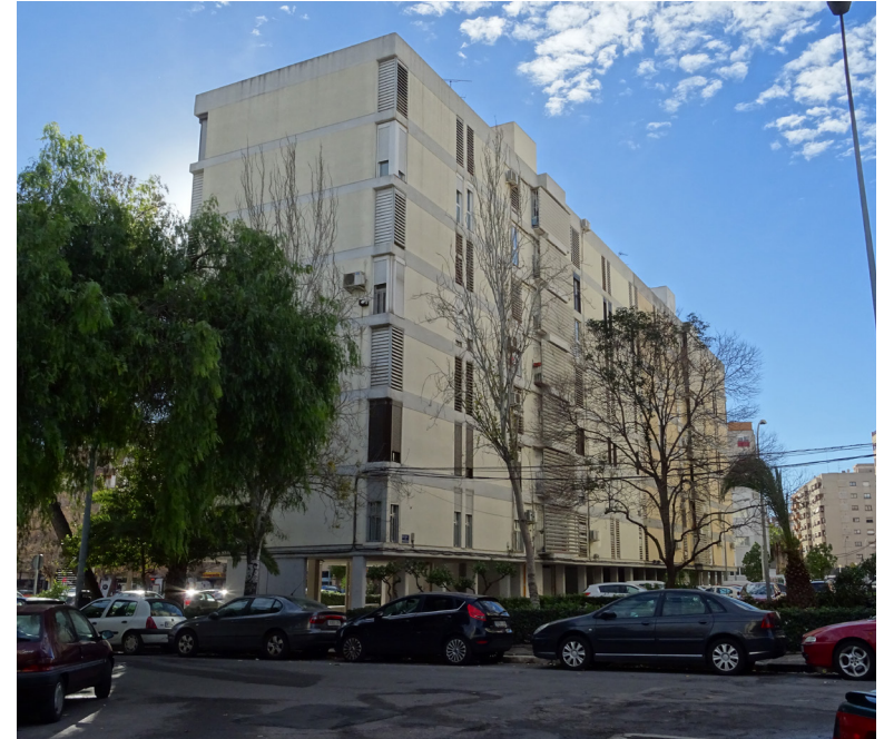
Imagen 3.23: Bloque A8-3 en el que se observan las plantas libres y los cantos de forjados de color gris.
