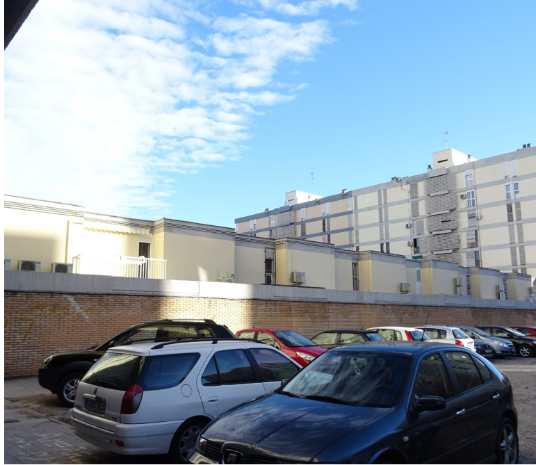
Imagen 3.28: Viviendas unifamiliares adosadas B2-3.
