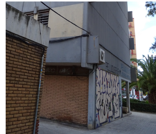
Imagen 4.3 y 4.4: Detalles de la estructura porticada sin lesiones aparentes (izquierda); Arranque y encuentro de fachada lateral y muro caravista (derecha)
