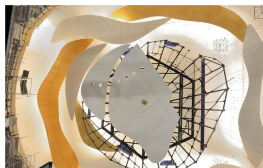
Imagen 3.2.8 Detalle superficie Philharmonie
