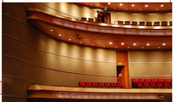
Imagen 4.3.8 Vista de la malla montada en el interior de la ópera
