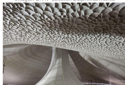
Imagen 3.1.8 Detalle superficie Elbphilharmonie
