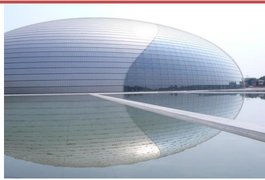
Imagen 4.3.1 Vista exterior Beijing National Theatre
