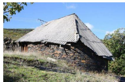
**13 Las pallozas, construcciones populares gallegas, han llegado a sustituir sus tradicionales cubiertas vegetales por nuevos productos procedentes de la industria o de los desechos de la construcción como el fibrocemento.**
