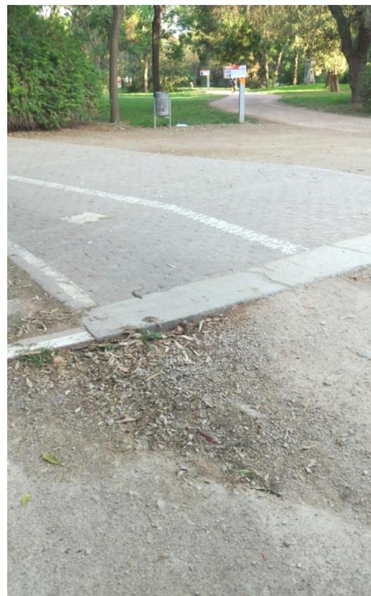
Imagen 24\_ Pavimento deteriorado en el Cauce Río Turia, Valencia. Fotografía del autor
