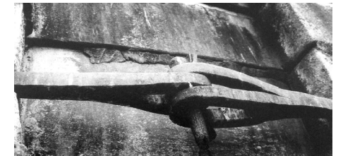
Figura 29. Anclaje de los zunchos metálicos localizados en la base de la cúpula.
