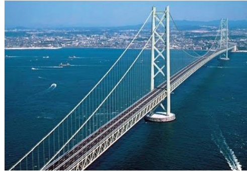
Figura 20: Gran Puente de Akashi kaikyo, en kobe-Awaji, Japón.
