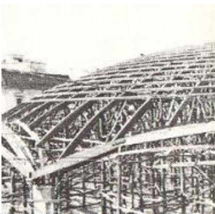
Figura 67: Cimbra de la cúpula.
