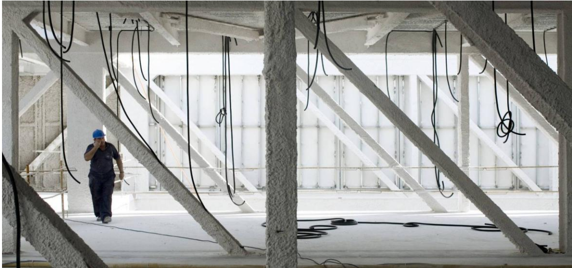
Figura 51: Imagen del interior una vez finalizada la estructura, que da una idea de la altura que alcanza la celosía sin ser necesario a su vez el uso de perfiles metálicos de gran área.
