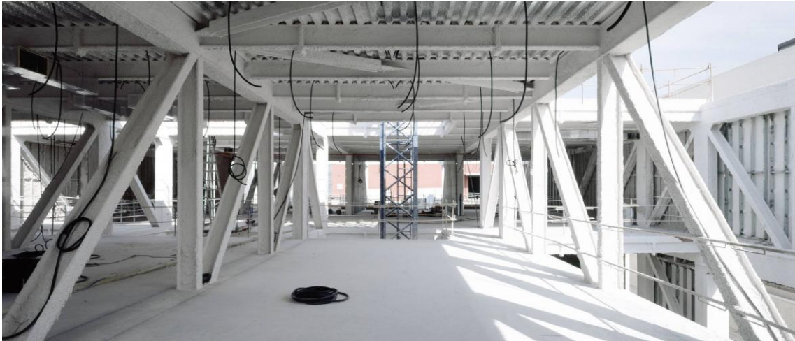
Figura 49: Vista de la estructura desde el interior durante la construcción.
