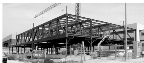
Imagen de la estructura durante la construcción.
