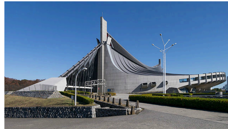
Imagen exterior del gimnasio, se puede apreciar el voladizo que se produce en las gradas y uno de los dos accesos al edificio, en el centro izquierda.
