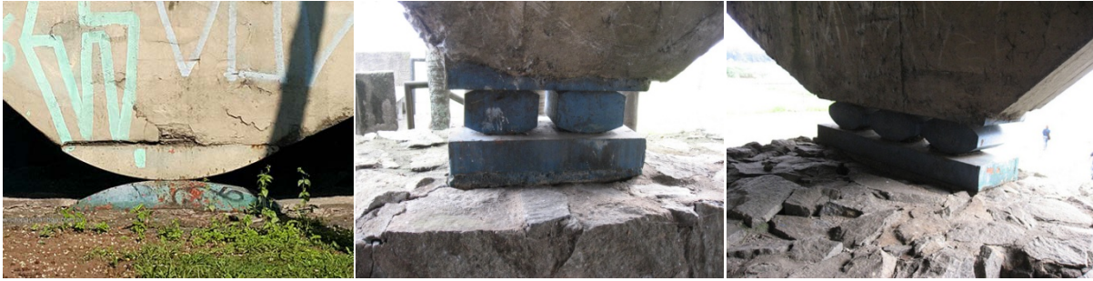
Imagen 27: Detalles de los apoyos de la cubierta del Garaje de Barcos del Club de Yates de Santa Paula Fuente: Blog de Luiz Seo
