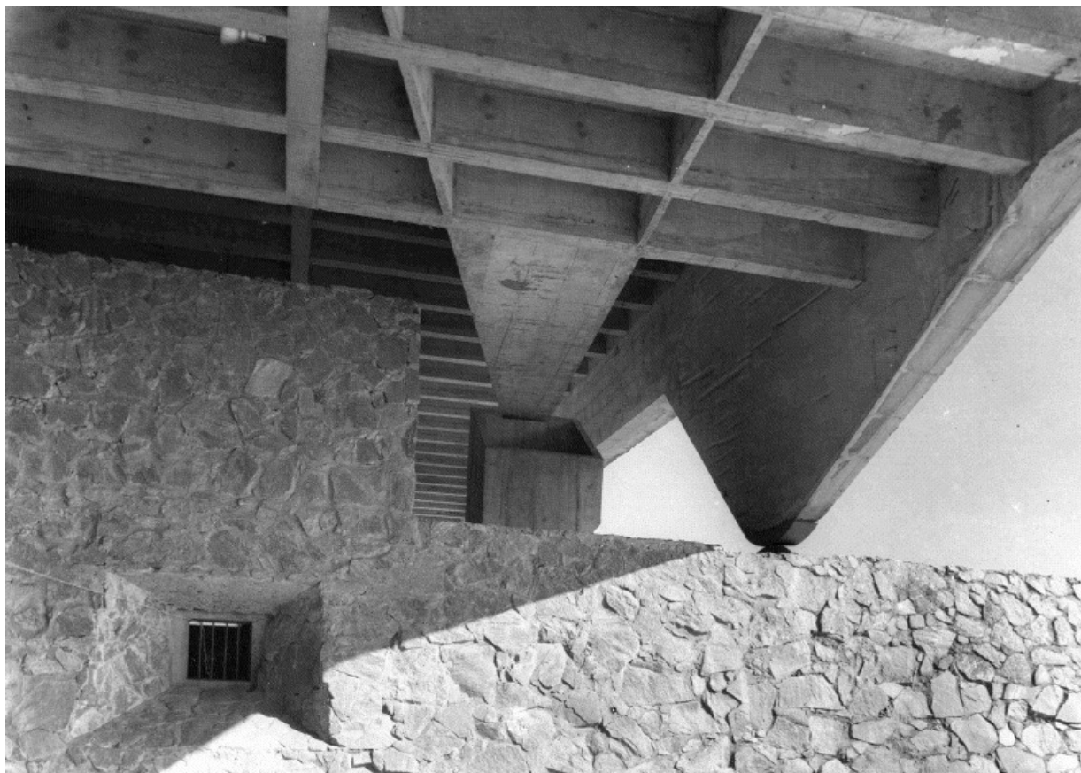
Imagen 26: Detalle de la losa nervada del Garaje de Barcos del Club de Yates de Santa Paula.
