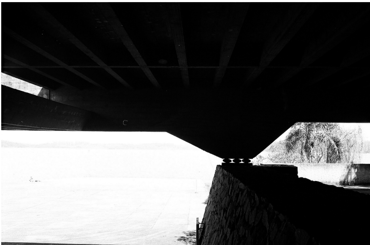
Imagen 28: Detalle del apoyo de la cubierta del Garaje de Barcos del Club de Yates de Santa Paula. Fuente: http://www.vilanovartigas.com/cronologia
