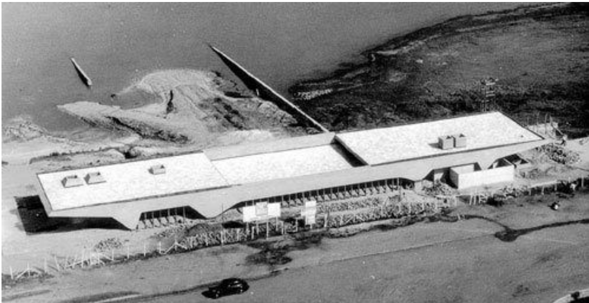
Imagen 17: Garaje de Barcos del Club de Yates de Santa Paula en construcción.
