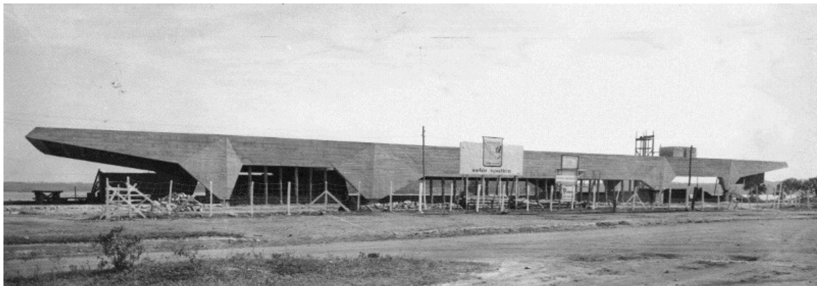
Imagen 22: Garaje de Barcos del Club de Yates de Santa Paula en construcción.
