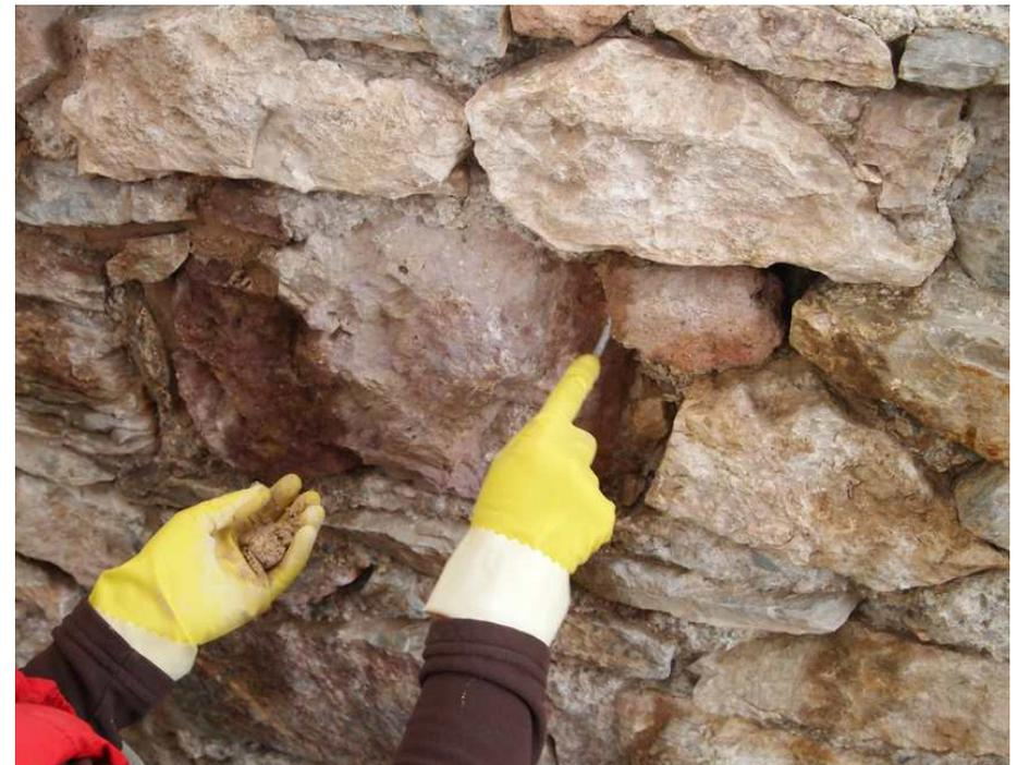
Figura 6\_ Consolidación muro de mampostería El Molinete, Murcia
