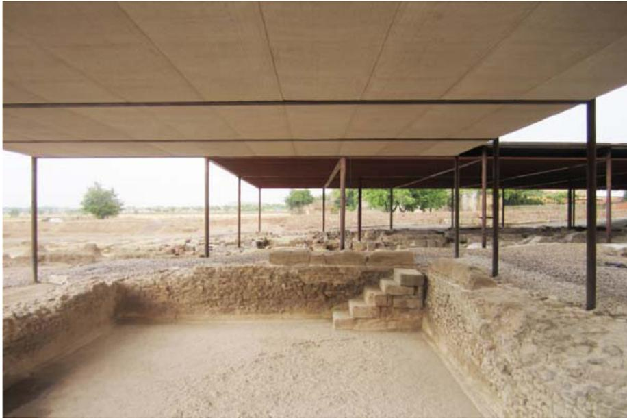
Figura 42\_Cubierta de protección
