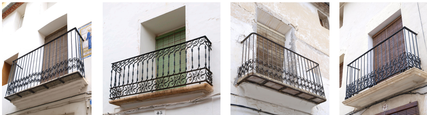
FIGURA 77. Balcons en voladís
