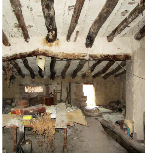
FIGURA 67. Començament de les voltes d'escala i estructura de la coberta
