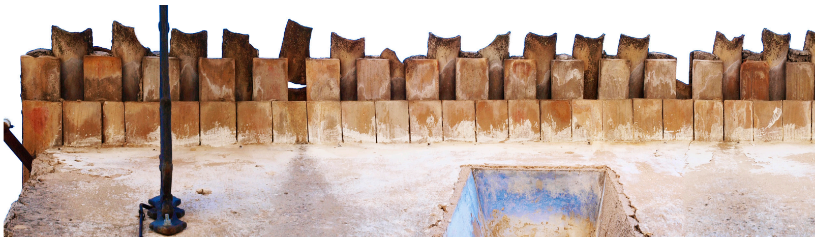
FIGURA 46. Vista zenital d'un ràfec d'un nivell de rajola massissa
