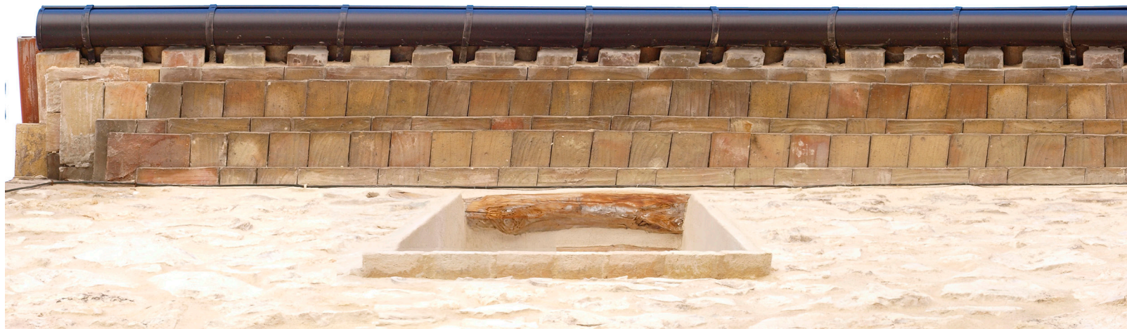
FIGURA 93. Vista zenital d'un ràfec de tres nivells ortogonals entre sí
