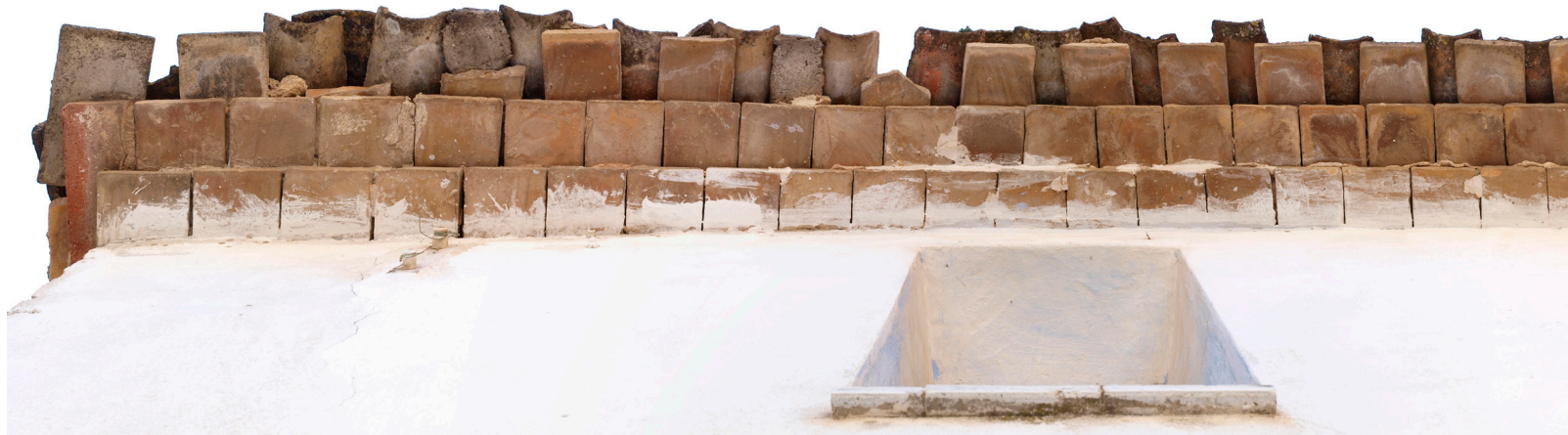
FIGURA 78. Vista zenital d'un ràfec de dos nivells de rajola massissa
