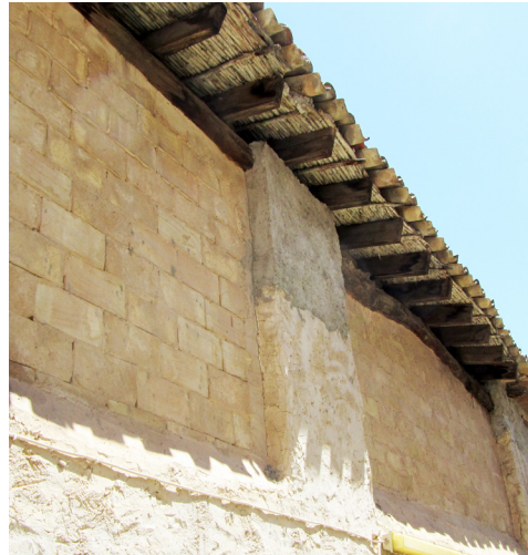
FIGURA 112. Estructura de la coberta i ràfec del corral del pati
