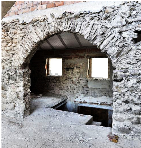
FIGURA 51. Arc de descàrrega de mamposteria i sistema estructural del sostre
