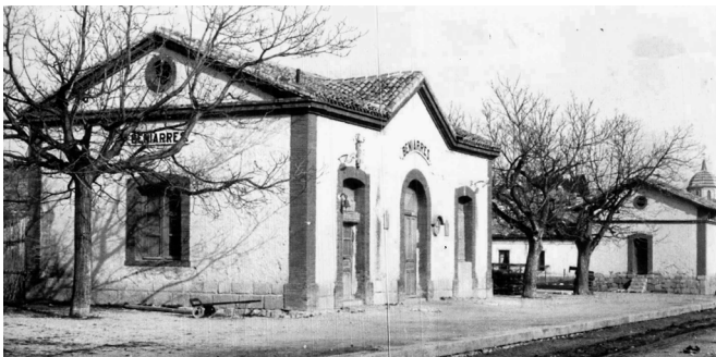
FIGURA 30. Estació de la línia de ferrocarril Alcoi-Gandia
