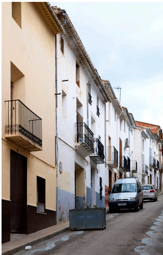
FIGURA 18. Cases edificades junt a la casa de l'Encomana, carrer Cova Santa
