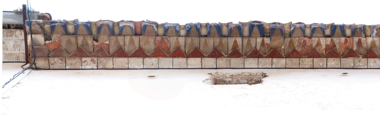
FIGURA 63. Vista zenital d'un ràfec en punta de diamant
