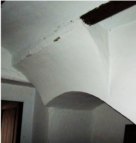
FIGURA 67. Començament de les voltes d'escala i estructura de la coberta
