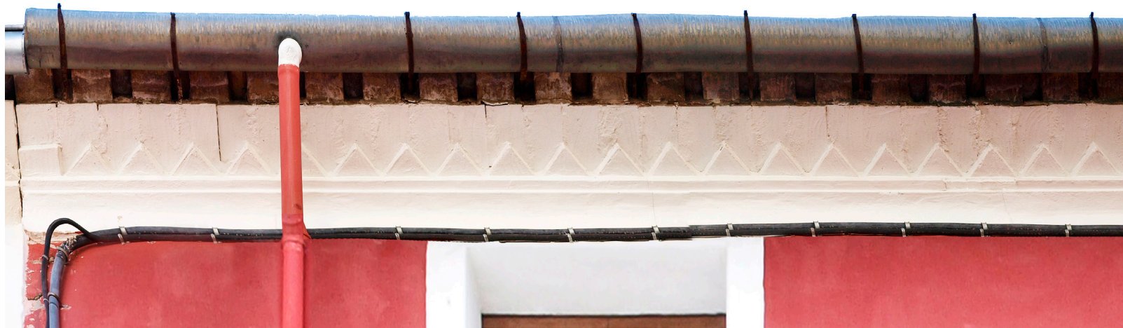
FIGURA 108. Vista zenital d'un ràfec en punta de diamant pintat i amb moldura d'escaiola
