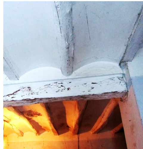
FIGURA 51. Arc de descàrrega de mamposteria i sistema estructural del sostre
