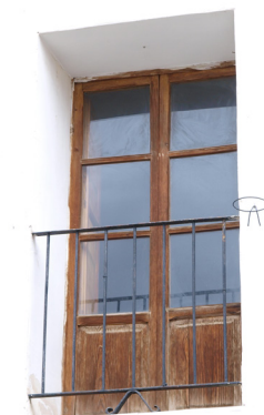
FIGURA 45. Balcons enrasats de fusta i forja
