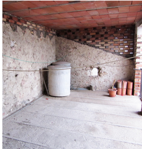
FIGURA 97. Sistema de fals sostre i recrescoda del nivell de coberta original
