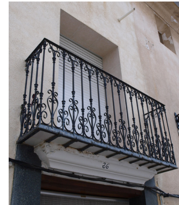
FIGURA 92. Balcons en voladís de forja amb moldura i de base de pedra
