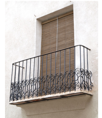
FIGURA 92. Balcons en voladís de forja amb moldura i de base de pedra
