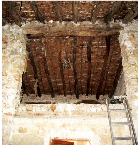
FIGURA 82. Sistema estructural de les obertures i de la coberta.
