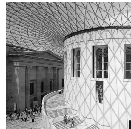
Imagen 02.81. Detalle de la cubierta
