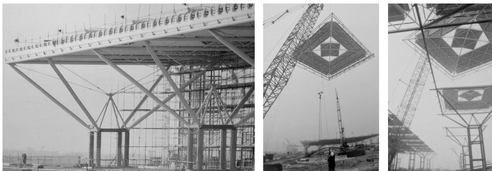
Imágenes 03.29 - 03.31. Construcción de la estructura metálica antes de los elementos de hormigón (Verano de 1987)
