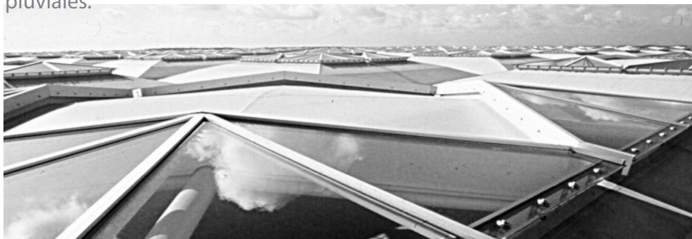
Imagen 03.38. Detalle de la cubierta de la terminal
