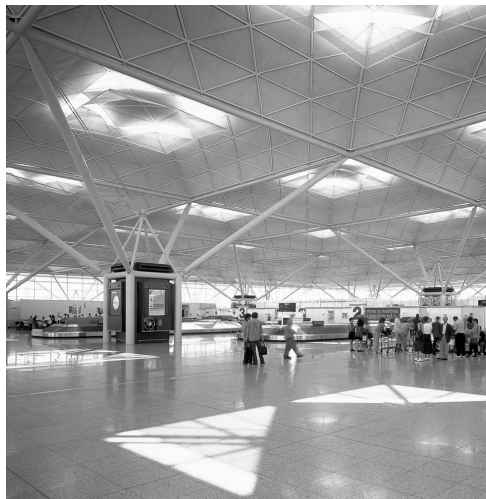
Imagen 06.01. Vista interior de la cubierta y la estructura
