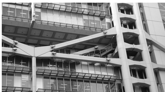
Imagen 02.45. Detalle de la estructura en fachada
