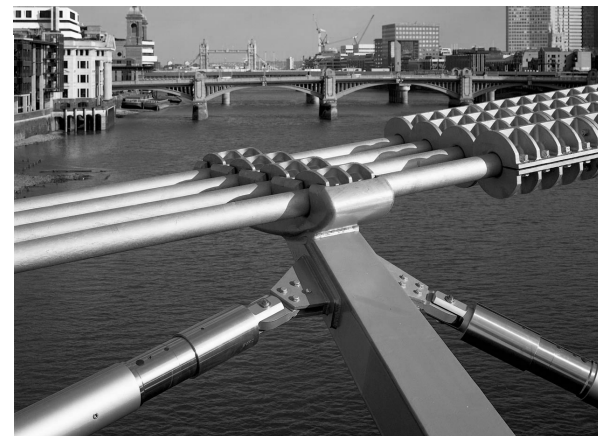
Imagen 02.87. Detalle de la estructura
