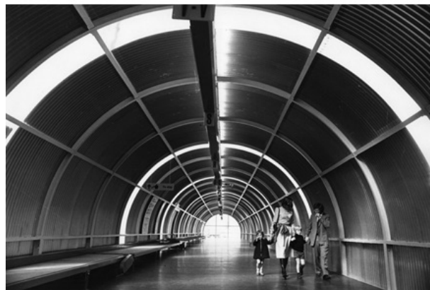
Imagen 02.34. Vista interior del túnel
