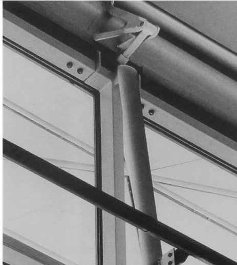
Imagen 03.43. Encuentro muro cortina y cubierta
