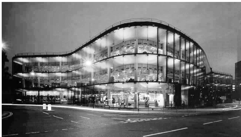
Imagen 02.40. Vista exterior nocturna
