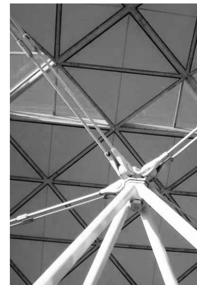
Imagen 04.04. Detalle de la unión de los tirantes
