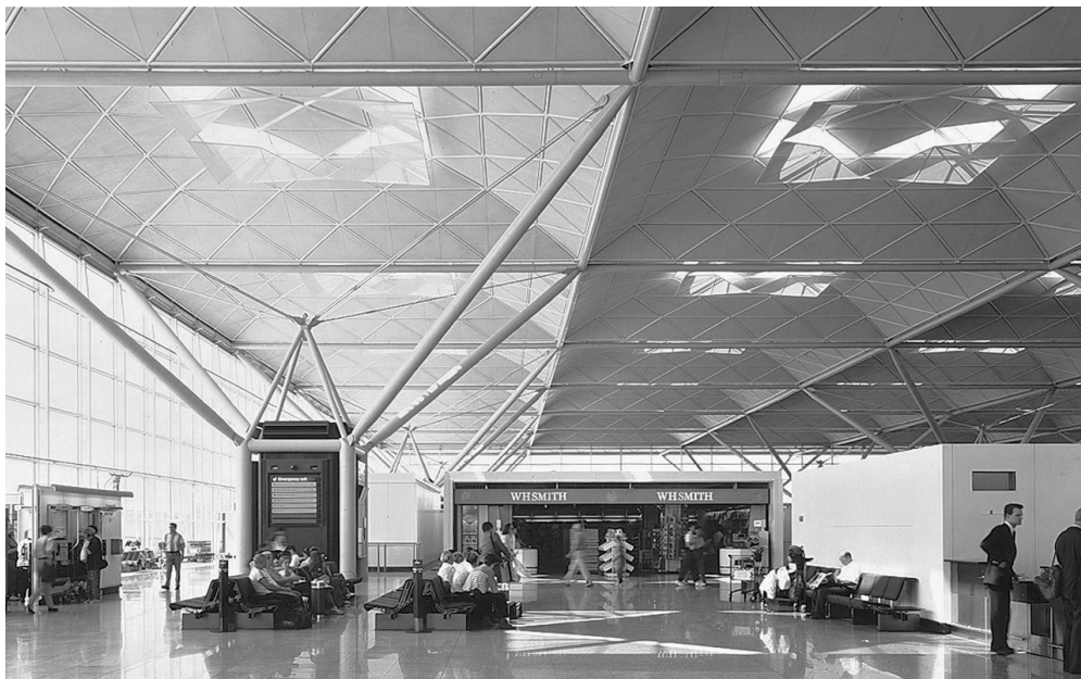
Imagen 03.39. El interior de la terminal iluminada por el cerramiento y los lucernarios
