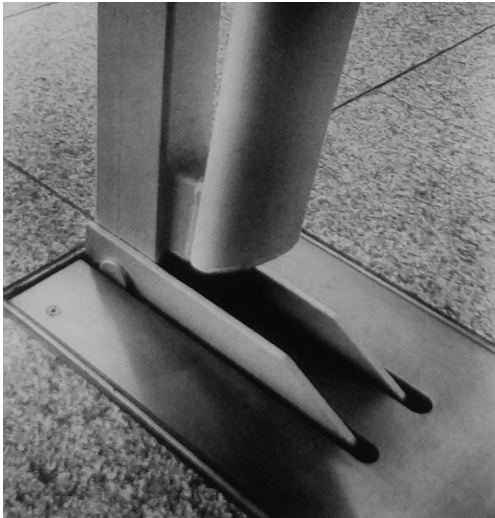
Imagen 03.42. Encuentro muro cortina y forjado
