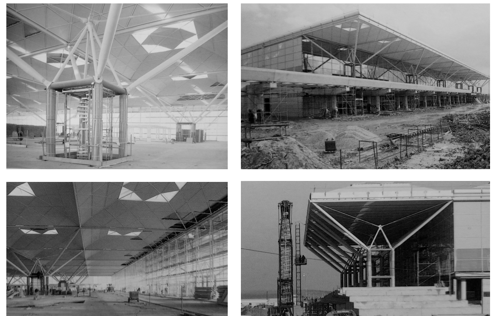
Imágenes 03.33- 03.36. Construcción de los elementos de hormigón ya finalizada (Principios de 1989)
