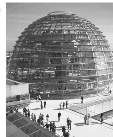
Imagen 02.75. Detalle de la cúpula
