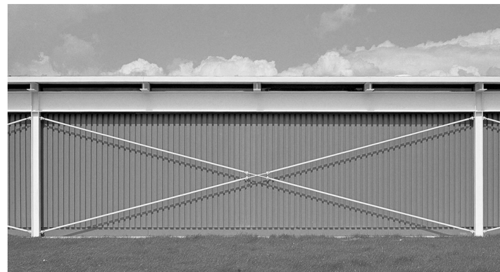
Imagen 02.30. Detalle del revestimiento metálico y de las riostras
