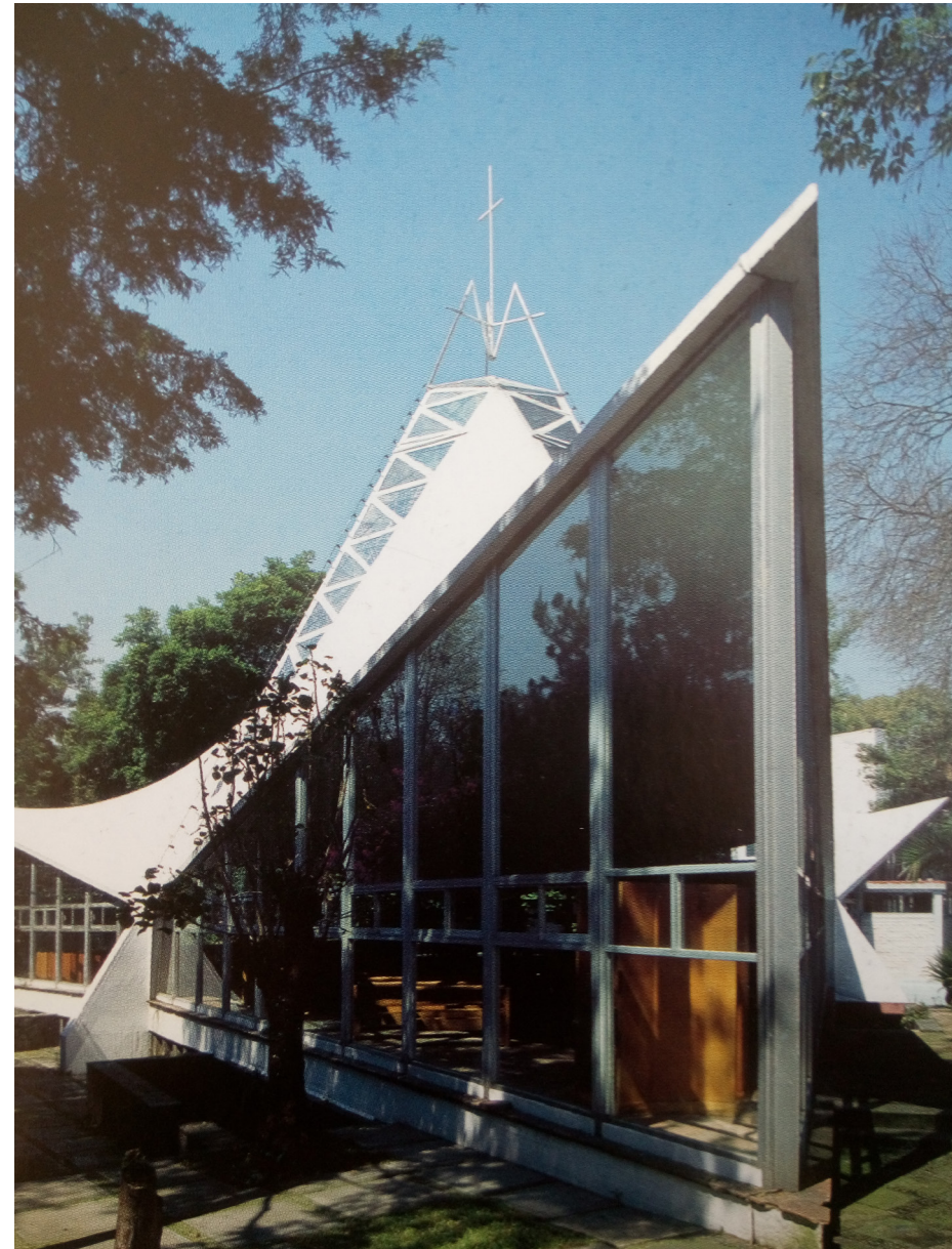
Imagen 3.26 Detalle vista exterior
