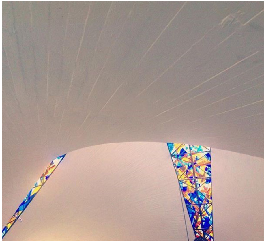
Imagen 3.25 Detalle de las marcas del encofrado en el hormigón
