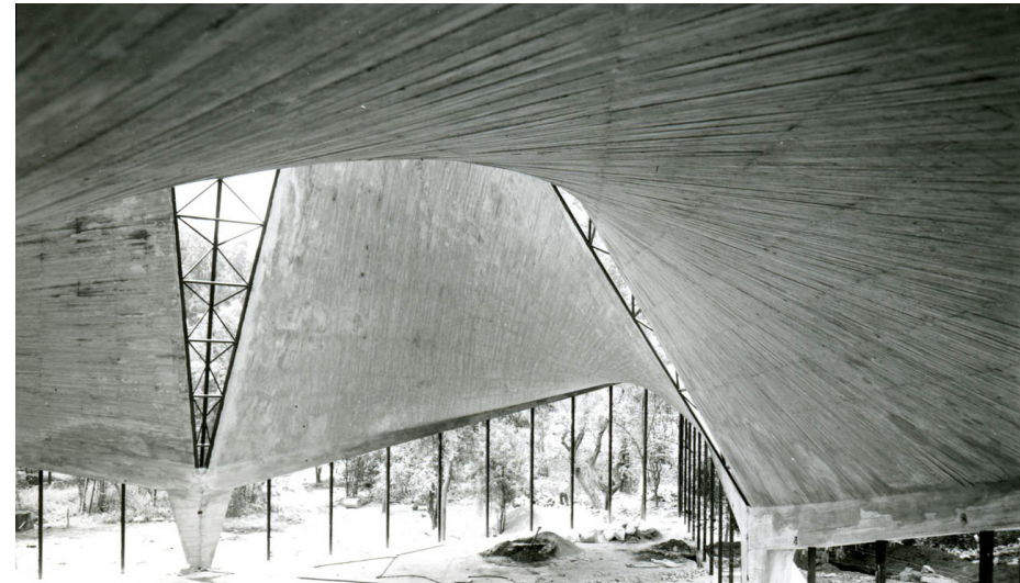
Imagen 3.22 Detalle vista interior de las marcas del encofrado
