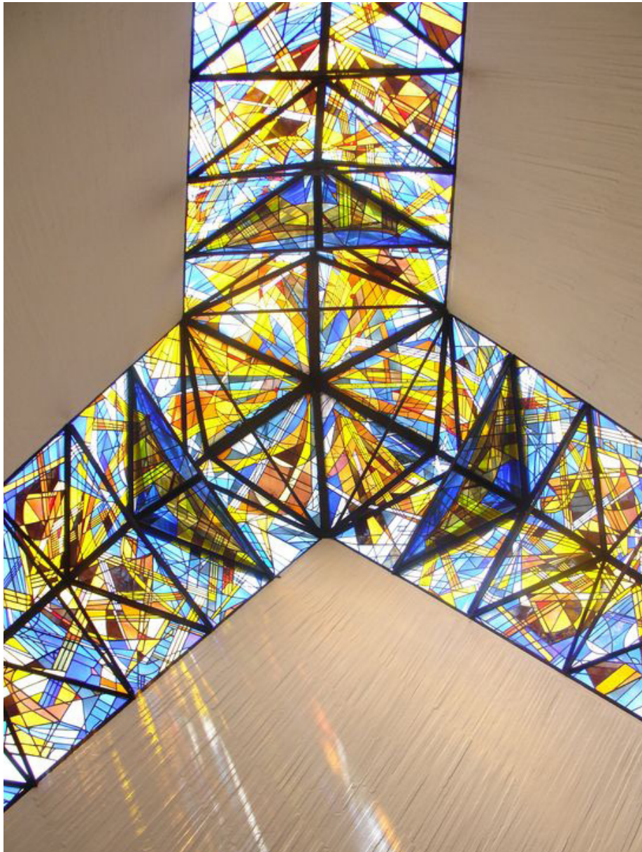
Imagen 3.27 Detalle unión de los tres paraboloides
