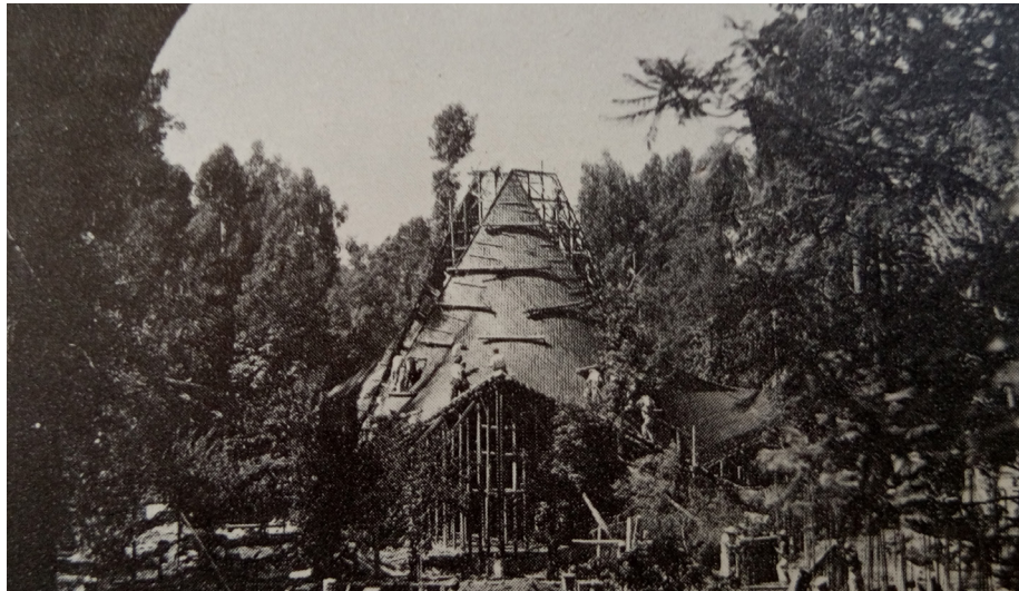
Imagen 3.21 Construcción del cascarón mediante cimbras
