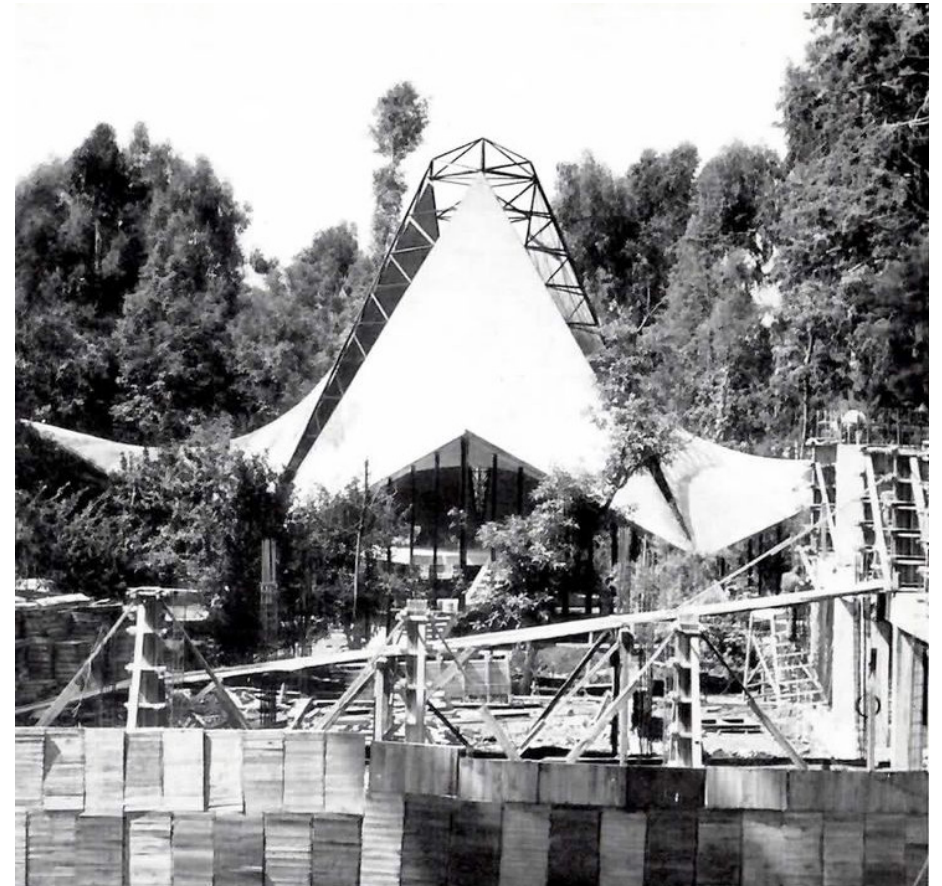
Imagen 4.12 Alzado real en construcción
