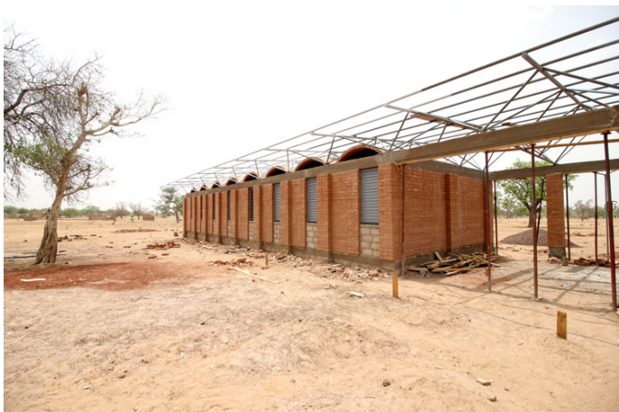
IMAGEN 110. Exterior del aula durante la construcción
