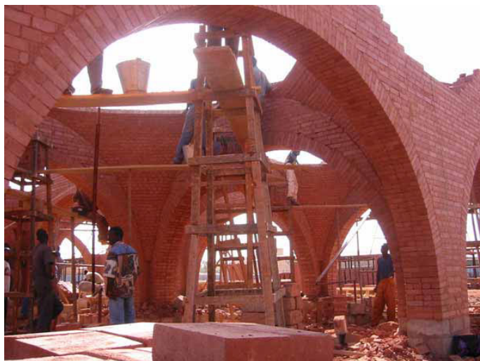
IMAGEN 53. Construcción de las cúpulas sin encofrado
