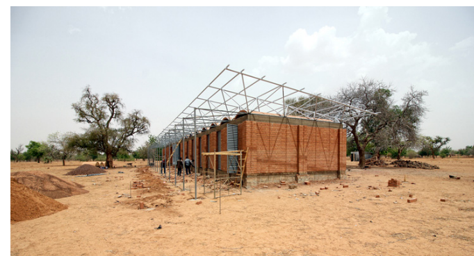
IMAGEN 114: Exterior del aula durante la construcción
