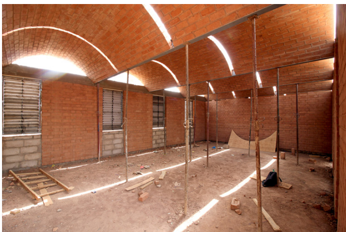
IMAGEN 111. Vista interior del aula durante la construcción
