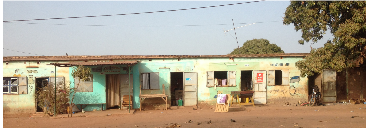
IMAGEN 116. Realidad constructiva en la actualidad
