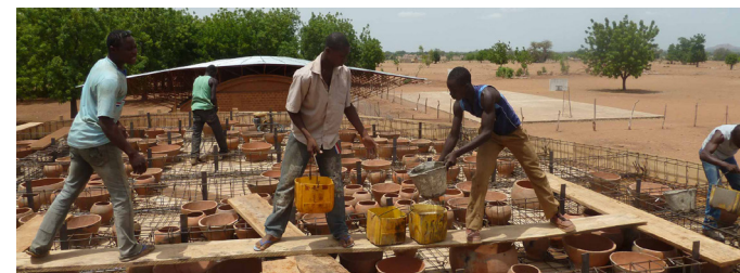
IMAGEN 88 Hormigonado de la cubierta de la biblioteca
