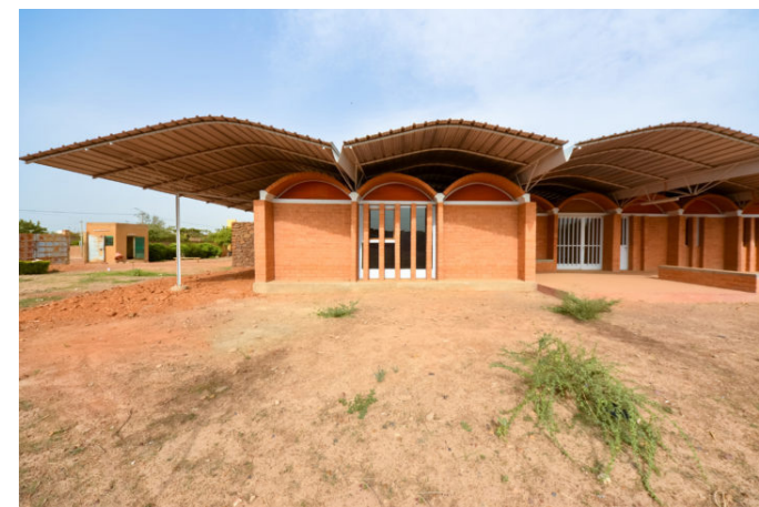
IMAGEN 71: Vista exterior del edificio
