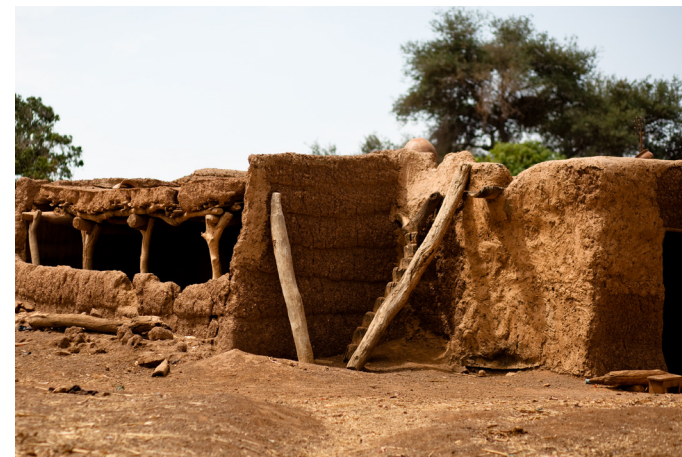
IMAGEN 37: Sistema de evacuación de agua de cubierta con refuerzo de los muros
