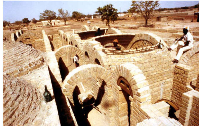
IMAGEN 44. Construcción de las cúpulas
