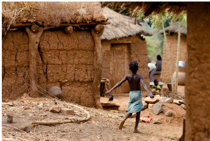
IMAGEN 30. Viviendas de muros de cob
