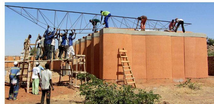
IMAGEN 92. Colocación de la cercha metálica que soporta la cubierta
