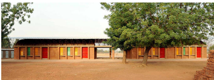
IMAGEN 83. Vista exterior de la ampliación del aula
