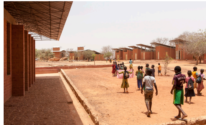
IMAGEN 101. Vista exterior del complejo
