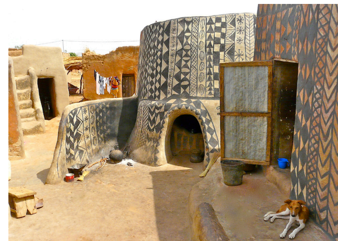
IMAGEN 27 Viviendas con muros de tierra moldeada
