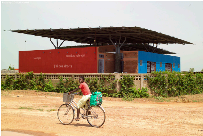
IMAGEN 62. Vista exterior del complejo
