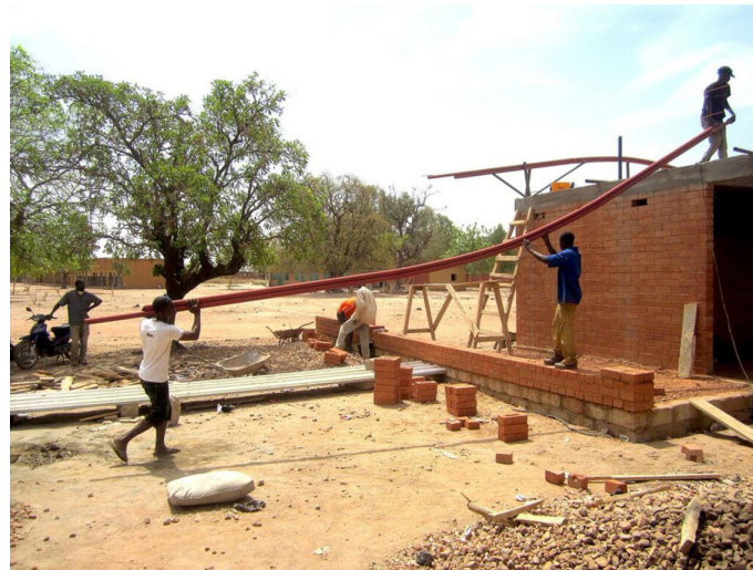
IMAGEN 74: Proceso de construcción
