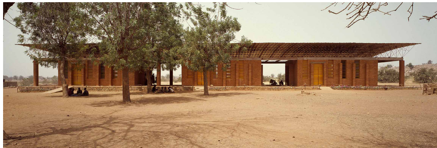
IMAGEN 80. Vista exterior de la escuela primaria
