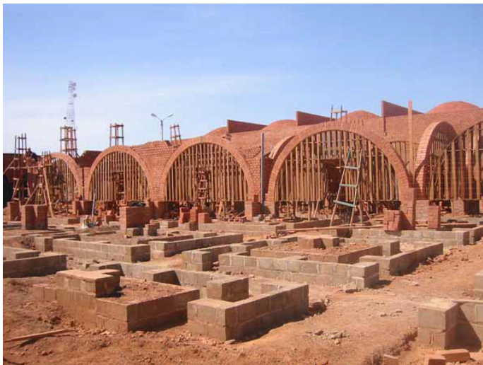
IMAGEN 52. Construcción de las cúpulas con adobes prensados
