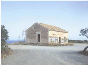
RPC_16_Antigua casa de peones camineros
