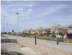
RPV_53_Recorrido de la Vía Verde a través de las urbanizaciones
