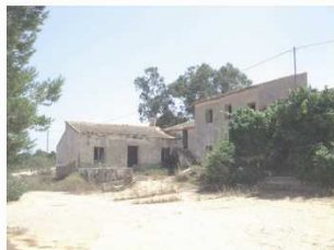
RPC_18_Arquitectura Tradicional en casas rurales (Casas de La Hita, de los Manteles, de las Majadas y del Garban- zuelo)
