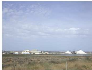
RPC_4_Conjunto de edificios, cintas transportadoras y depósitos (montañas) para la producción de sal.
