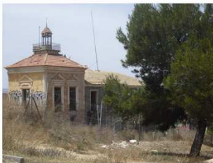
RPV_55_Casa de Los Balcones
