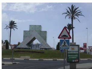
RPV_67_Rotondas de acceso a Torrevieja desde la carretera CV905
