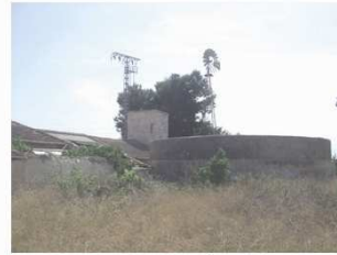
RPC_11_Conjuntos hidráulicos de Lo Reche y La Molineta
