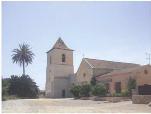
RPC_9_Arquitectura Tradicional en los huertos tradicionales de la Laguna de Torrevieja (conjunto de La Marquesa, Lo Reche, Morales, La Cisterna, Del Reloj y Lo Blanch)
