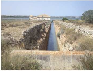
RPC_1_Canal de las Salinas: Canal de aproximadamente 7 m de anchura y 1.600 m de longitud que permite pasar agua desde la laguna de La Mata a la de Torrevieja
