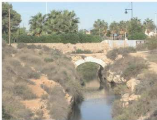
RPC_3_Acequión de Torrevieja y puente: Canal de aproximadamente 9 m de anchura y 2.000 m de longitud construido, al igual que un antiguo puente de sillería, en el siglo XV con el objeto de conectar el Mar Mediterráneo con la laguna de Torrevieja
