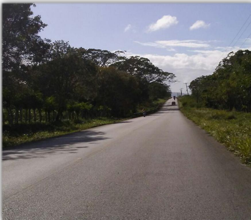
Figura 16. Ausencia de tachas reflectantes en la carretera El Seibo - Hato Mayor.
