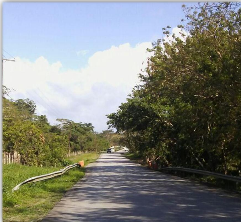
Figura 18. Barrera de contención mal colocada en la carretera El Seibo - Hato Mayor.
