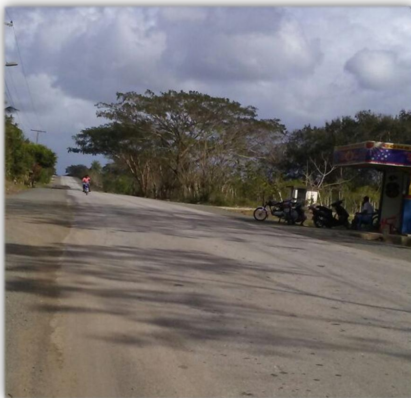
Figura 15. Ausencia de señalización horizontal en la proximidad de una intersección en la carretera El Seibo - Hato Mayor.
