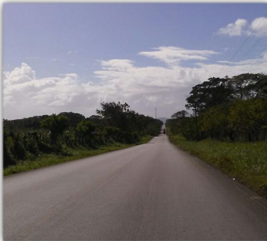
Figura 14. Ausencia de señalización vertical en la carretera El Seibo – Hato Mayor.
