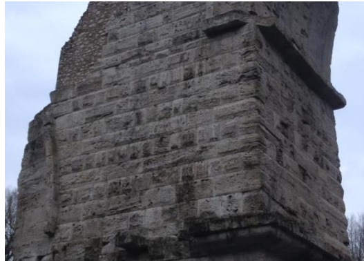
Figure 5: Example of opus quadratum (Ponte di Narni).
