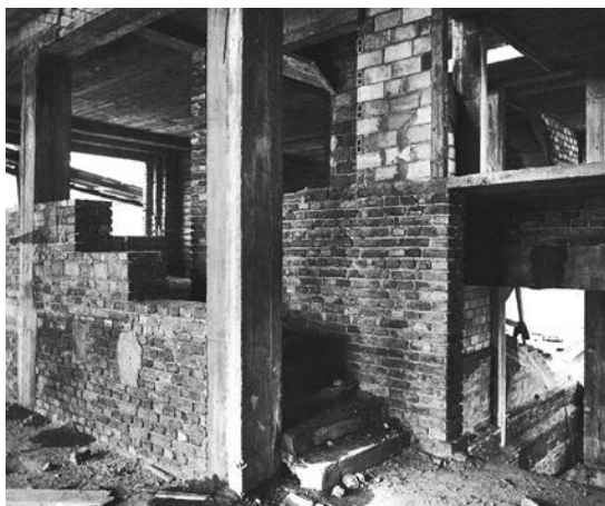
[20] Adolf Loos, villa Müller, Praga, 1930. Muro de articulación de niveles, en construcción. UPM Archive Prague. En The Müller Villa in Prague , City of Prague Museum, 2002.
