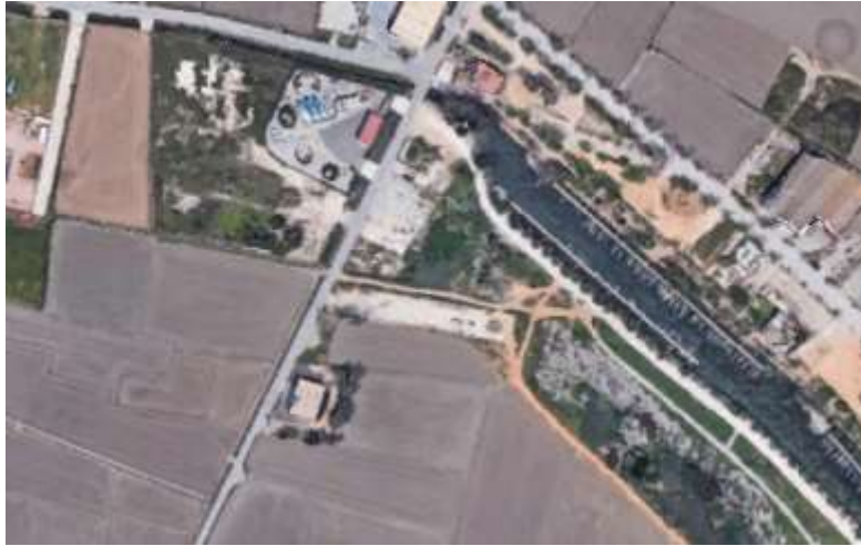
Figura 2. Estación de bombeo y puerto de Catarroja
