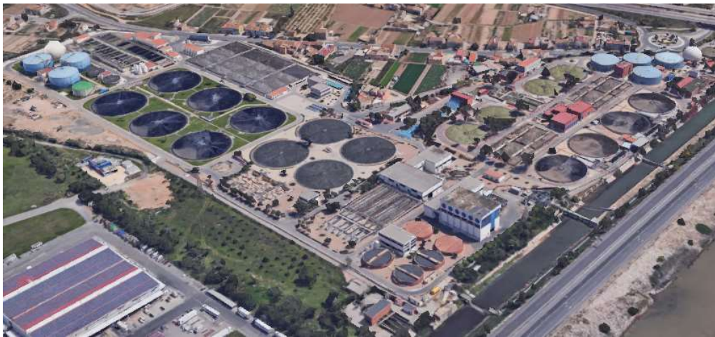
Figura 4. Estación Depuradora de Aguas Residuales de Pinedo (Valencia)
