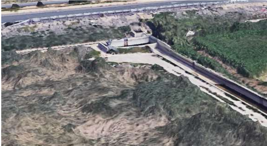
Figura 6. Toma de agua de la Acequia del Oro
