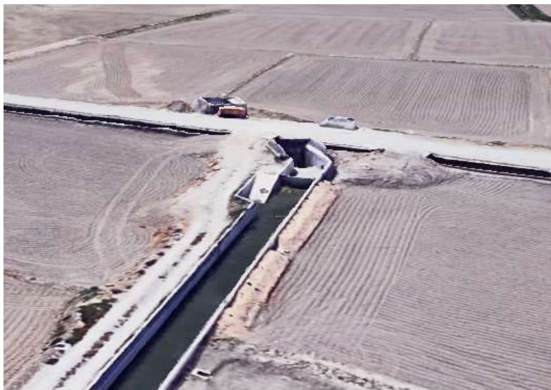
Figura 9. Cambio de sección de canal a cielo abierto a tubería en carga
