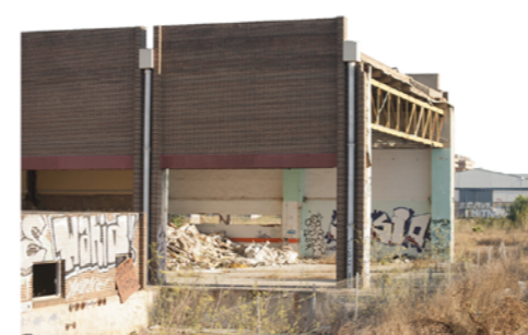
Nave servicios generales
