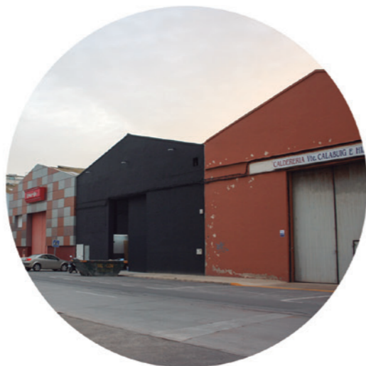
5-Naves industriales en uso
