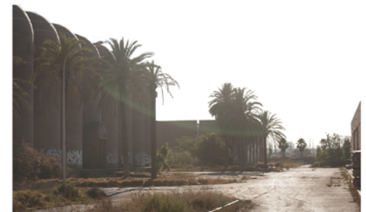
Acceso este y fachada norte
