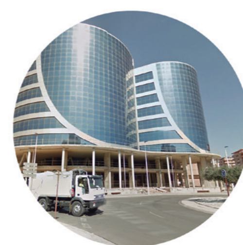
● 15-Edificio de oficinas en proceso de construcción
