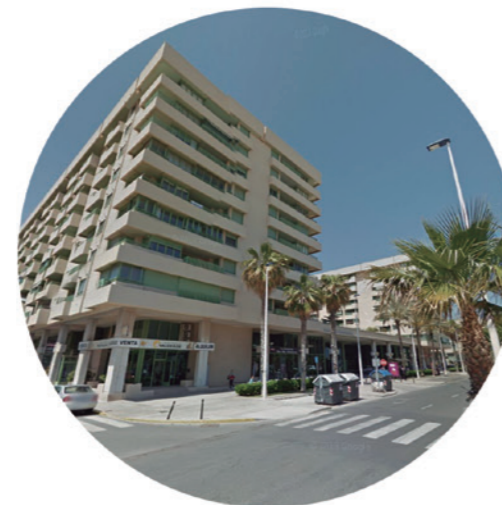
● 13-Edificio Malvarrosa: su zócalo son bajos comerciales y el Centro de Salud
