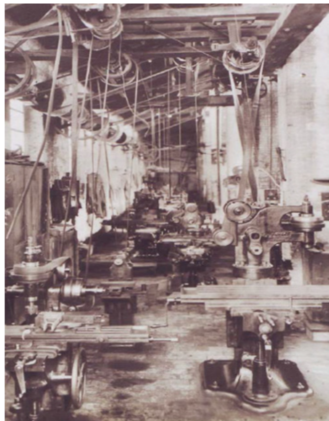
Sala de tornos de La Maquinista Valenciana
