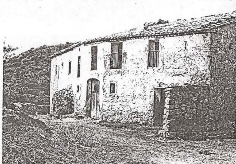
Fachada Este. Obsérvese el cambio de dirección de la casa añadida. Bóveda de cubrición del pozo adosado a la fachada de la casa antigua.
