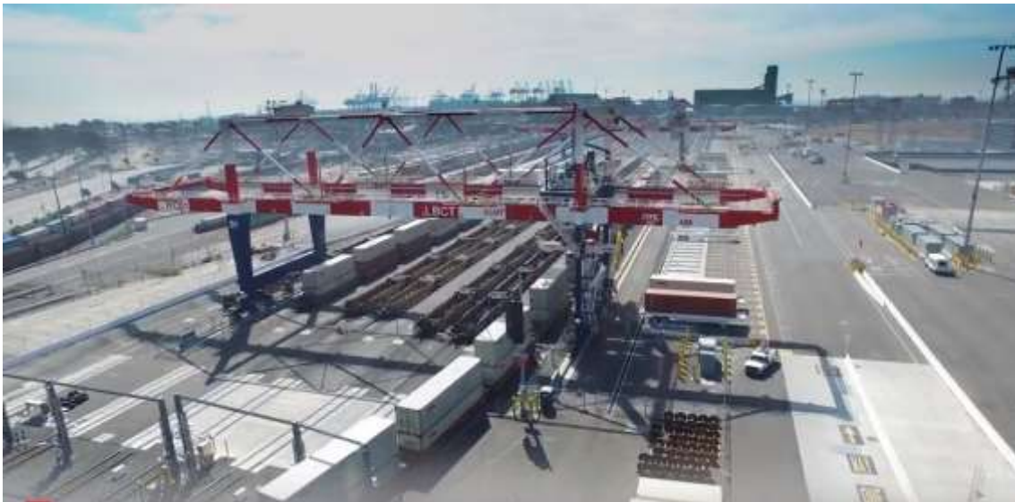
Figura 19 - Grúas Pórtico de la terminal ferroviaria de la LBCT. Fuente: Youtube.
