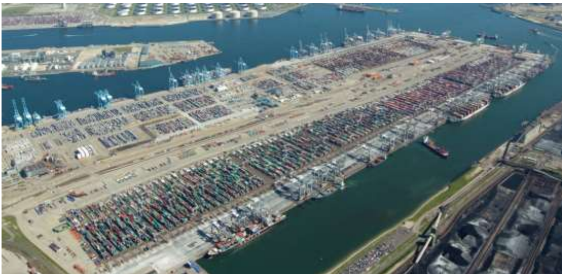
Figura 17 - Vista aérea de la ECT Delta Terminal de Rotterdam. Fuente: google images.
