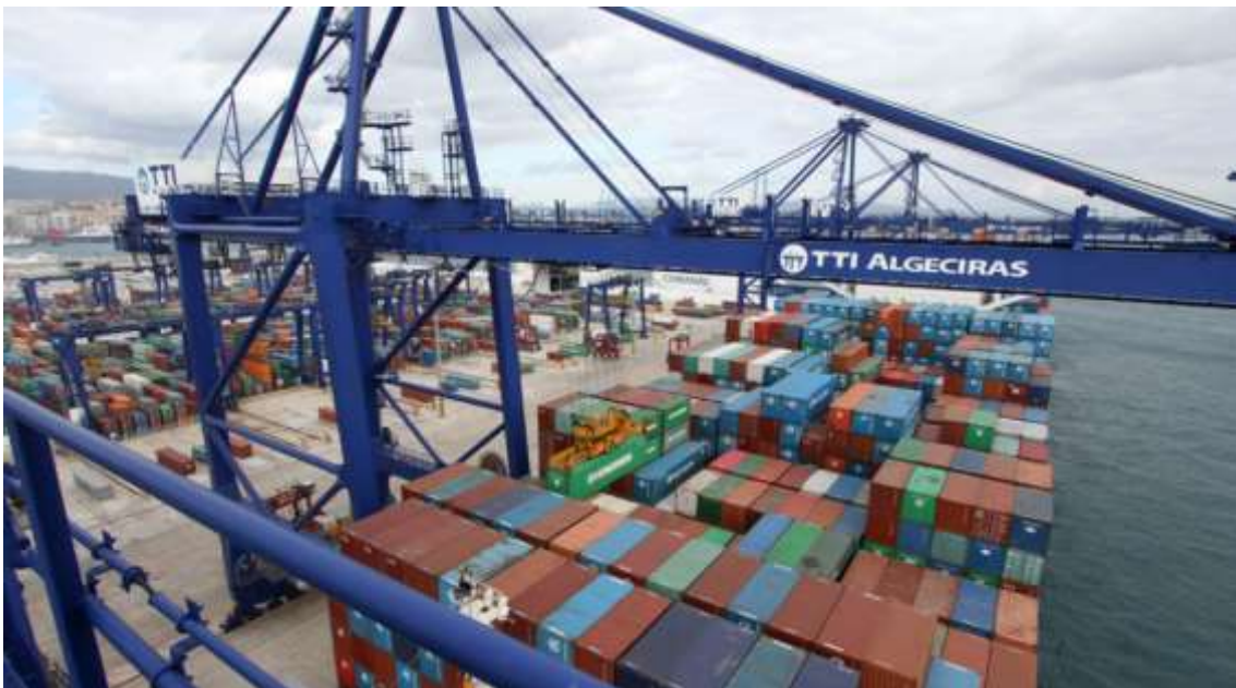
Figura 29 - Grúas pórtico de muelle realizando la operación de descarga en la TTI Algeciras (España). Fuente: www.apba.es .
