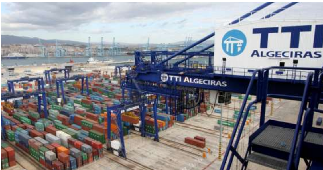
Figura 30 - Zona de almacenamiento de la TTI Algeciras. Fuente: www.apba.es .
