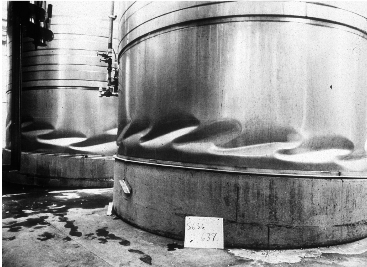
Abolladura por torsión
