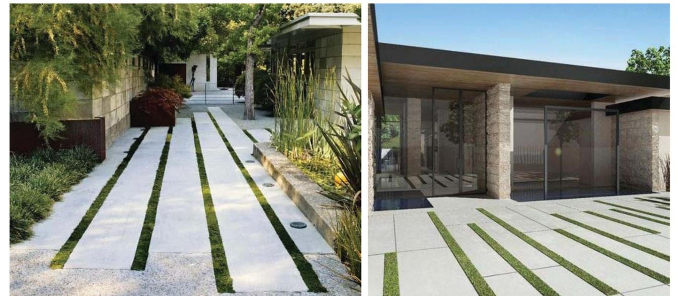
Por otro lado, en los espacios exteriores que “salen” de las edificaciones, al querer darle continuidad a esos espacios, se utiliza el mismo pavimento del interior, pero sin el sistema de suelo técnico. Se emplea la misma placa cerámica que se utilizaba de revestimiento en el sistema, pero aplicada directamente sobre la solera, previamente tratada, mediante un mortero cola especial para ese tipo de trabajos.
