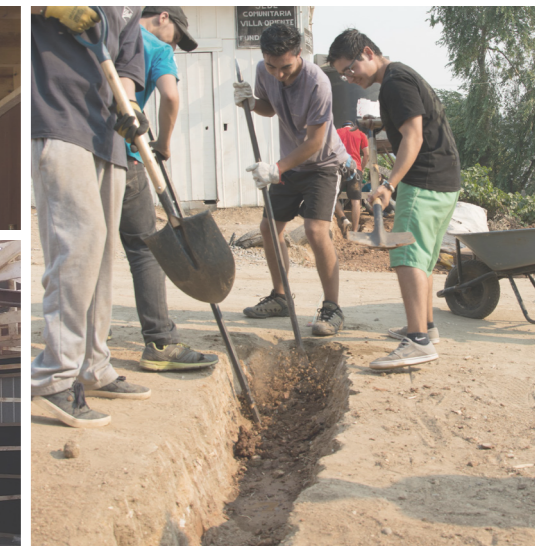
excavación de zanja para saneamiento en sede Río Aconcagua
