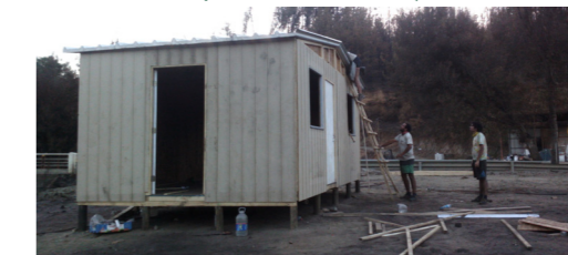
TDE en Empedrados: construcción de una vivienda de emergencia para una familia afectada por los incendios de enero en el sur del país.
