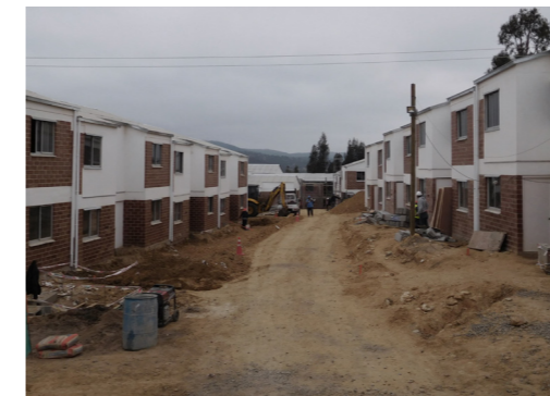
Fotos del proyecto "Los Fundadores", en ejecución. Se trata de un proyecto de vivienda social para personas en situación de campamento que cuenta con TECHO como Entidad de Gestión Inmobiliaria Social.
