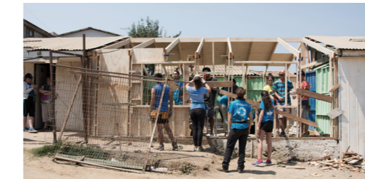
TDV 2017 - mejoramiento de sede social previamente demolida
