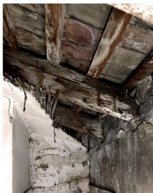
Fig 4.46. Detalle cubierta inclinada con tablero de rasillatrasdosada con estructura de estructura de cañizo y yeso. Ficha de catálogo: Qp4-333.
