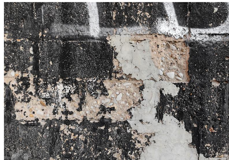
Fig 4.60. Muro de bloque conglomerante-tierra.
