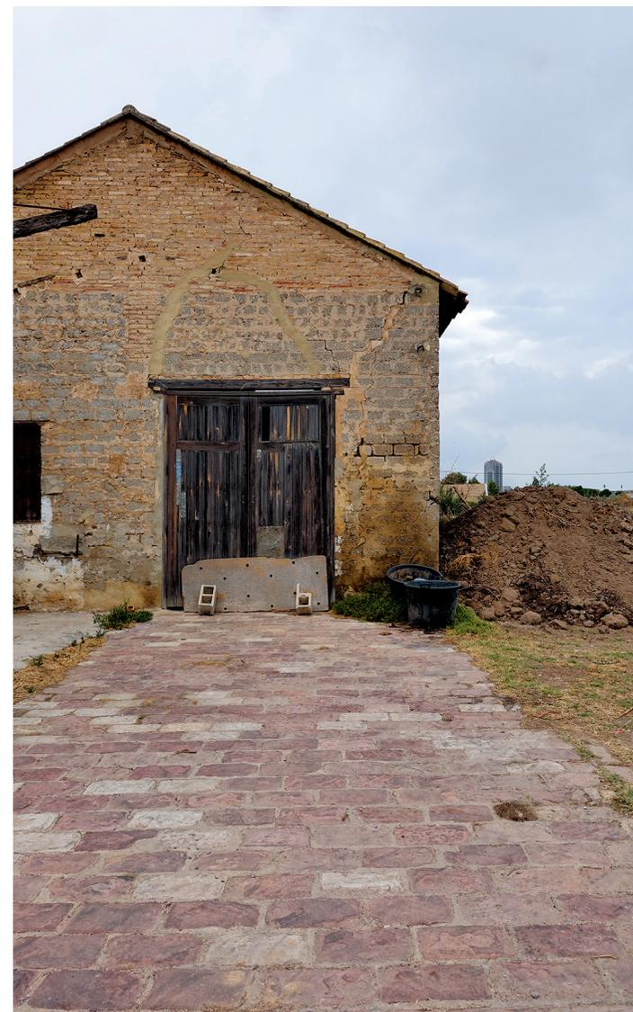
Fig 4.9. Acceso nave con camino pavimentado con baldosas de piedra de rodano. Ficha de catálogo: Qp9-200.
