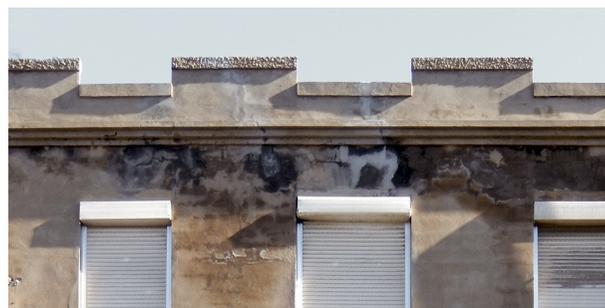
Fig 5.12. Ejemplos de frontones que presentan patología. Ficha de catálogo de arriba a bajo: Qp17-021, Qp9-233, Qp24-048.
