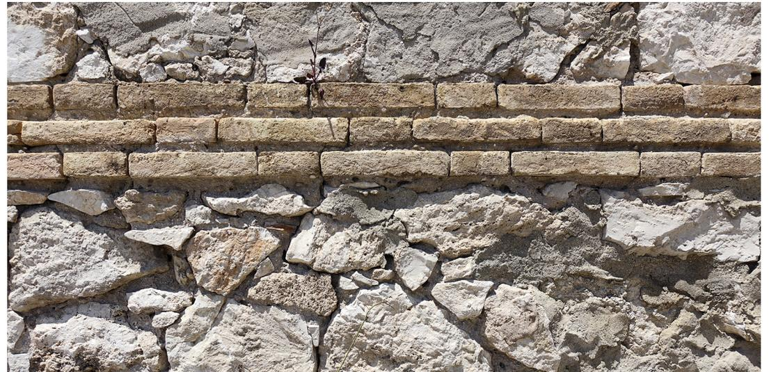
Fig 4.56. Detalle de muros de mampostería. Superior, mampostería ordinaria; inferior, mampostería concertada con refuerzos de ladrillo.
