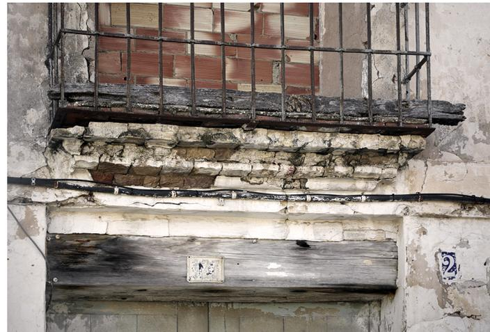
Fig 4.42. Detalle balcón tipo vuelo de forja con repisa. Fica de catálogo: Qp17-079.
