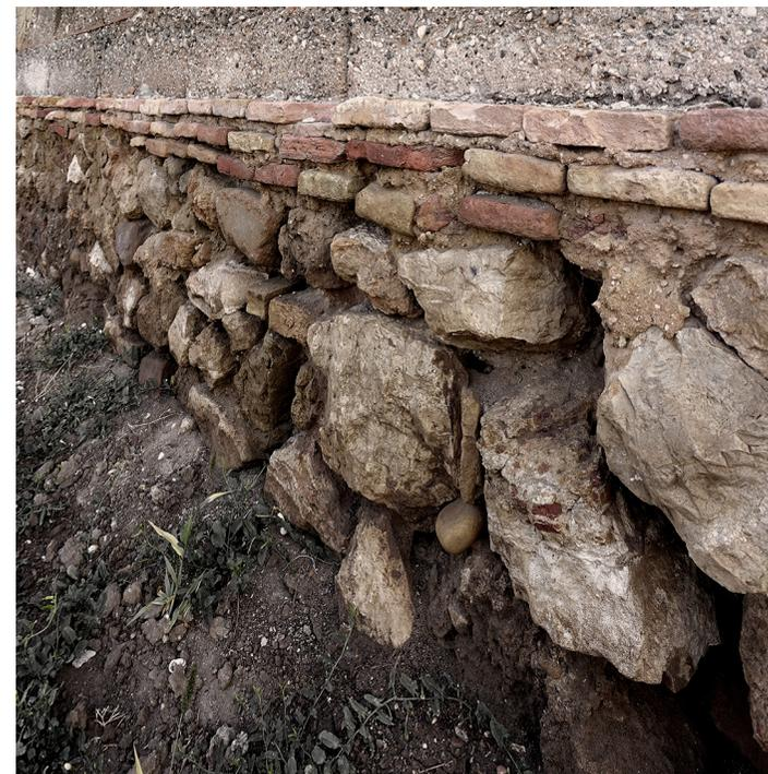
Fig 4.37. Cimentación y arranque de muro de mampostería.
