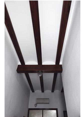
Fig 4.38. Forjado de revoltón y viguetas de madera de la construcción Qp9-191.
