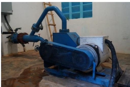
Figura 5: Turbina tipo flujo cruzado
