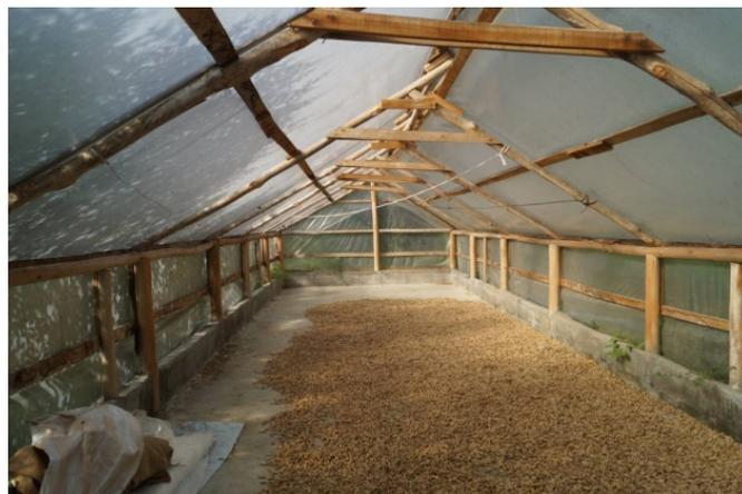
Figura 30: Ejemplo para la estructura de un secadero
