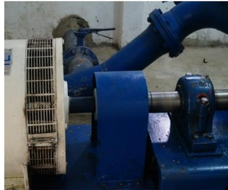
Figura 8: Acople mecánico turbina-generator
