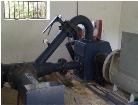
Figura 7: Turbina tipo Pelton
