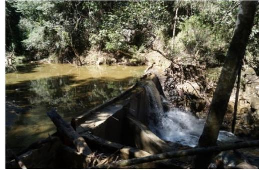
Figura 2: Compuerta de paso al desarenador
