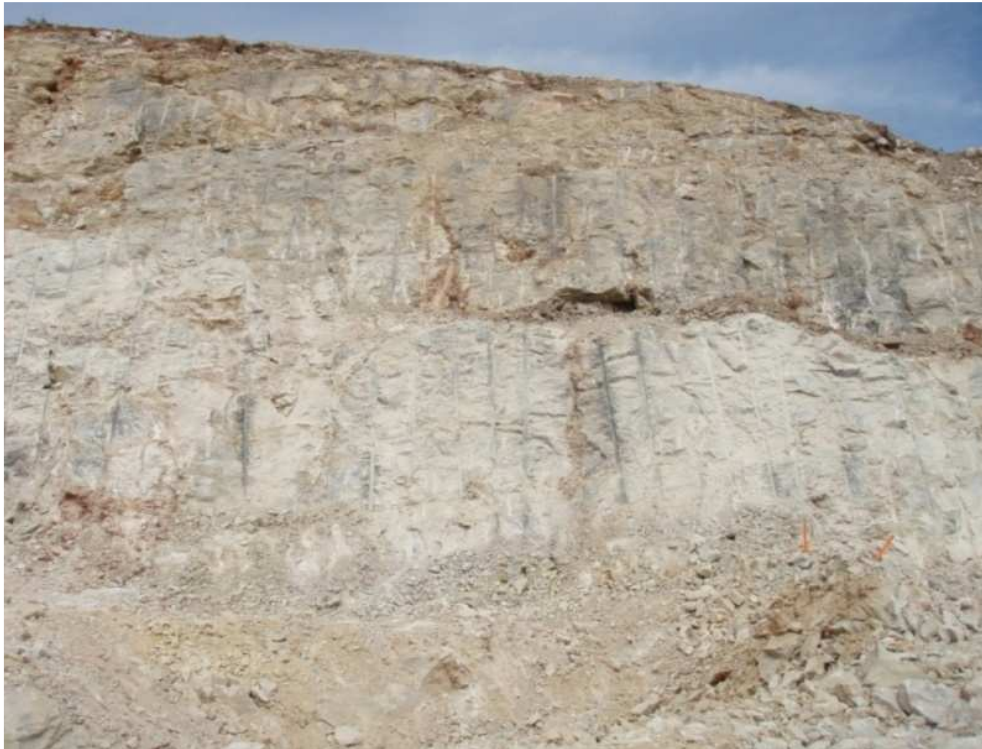
FIGURA – 37: DETALLE DEL DESMONTE Nº 8 DE LAS OBRAS DE LA CV – 13. (FUENTE: ELABORACIÓN PROPIA).
