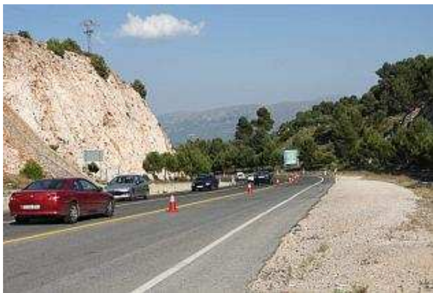
FIGURA – 92: TRAMO DE LA ANTIGUA N-340, APROVECHADO PARA LA AMPLIACIÓN DE LA A-7.
