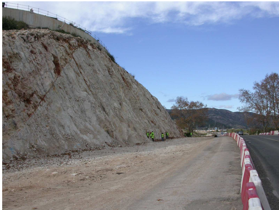
FIGURA – 76: DESMONTE EN ROCA ENTRE LOS PK 1+680 Y 1+830 DE LAS OBRAS DE DESDOBLAMIENTO DE LA N-332, TRAMO GANDÍA – XERESA.
