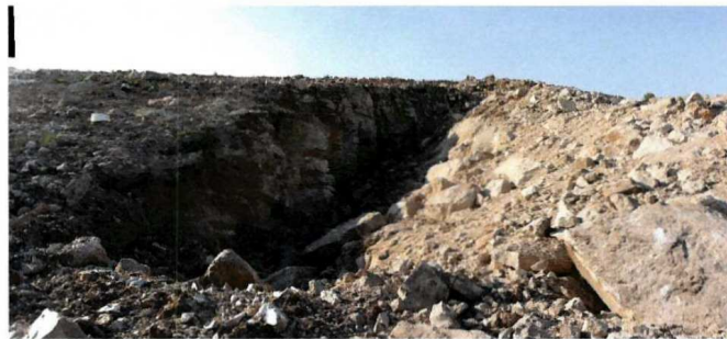
Tramo inicial. Posible colapso de una cavidad cárstica tras una voladura.
