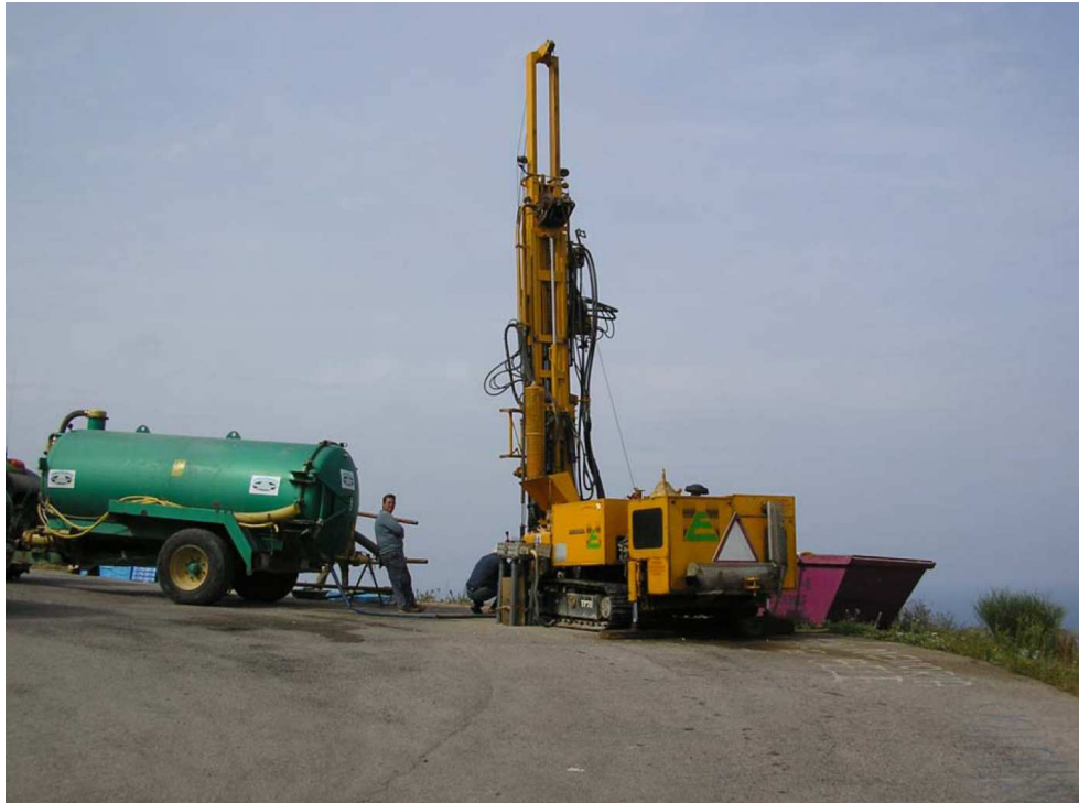
FIGURA – 59: EJECUCIÓN DEL SONDEO S – 1. (FUENTE: IVA-LEYING, 2008).
