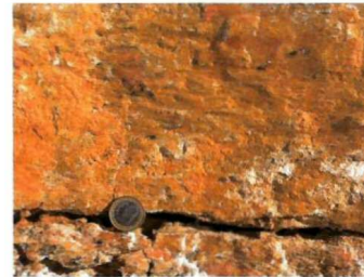
Detalle del espejo de falla.
