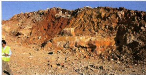
Tramo inicial. Falla.
