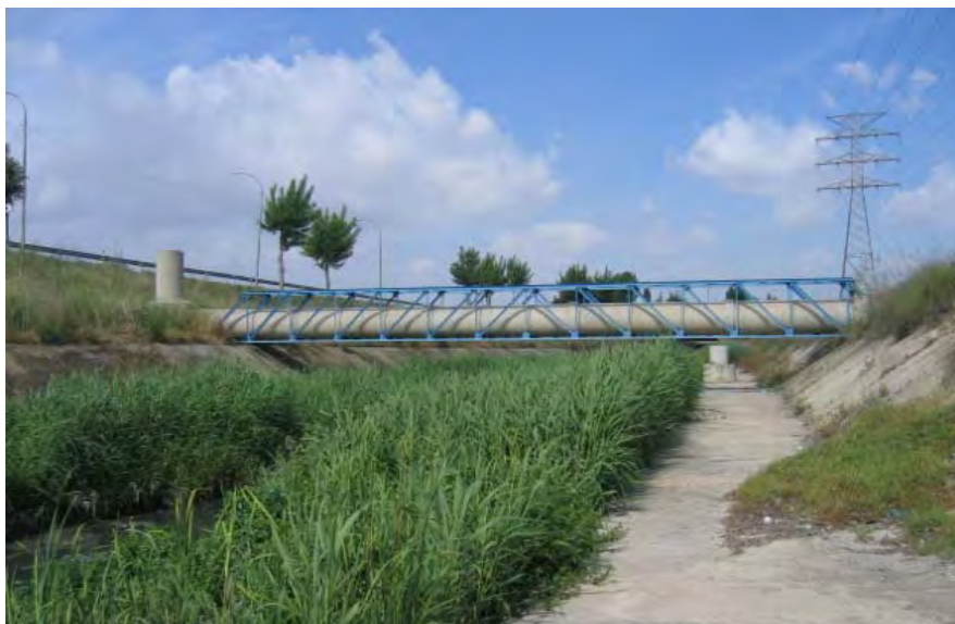
Figura 2-63. Cruce del azarbe de la margen izquierda del Turia
