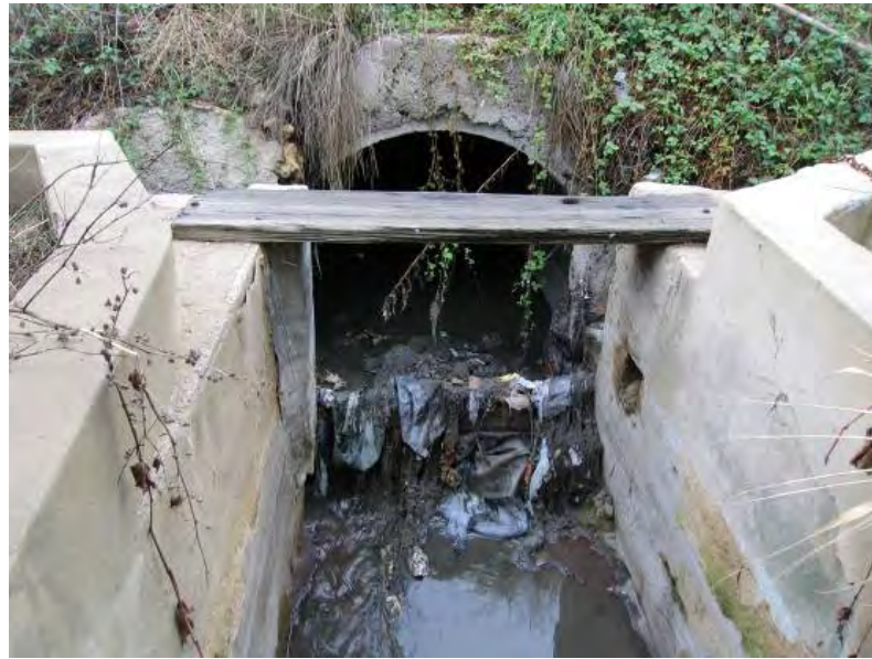
Figura 2-28. Braç Nou de Sedaví aguas abajo de la V—1
