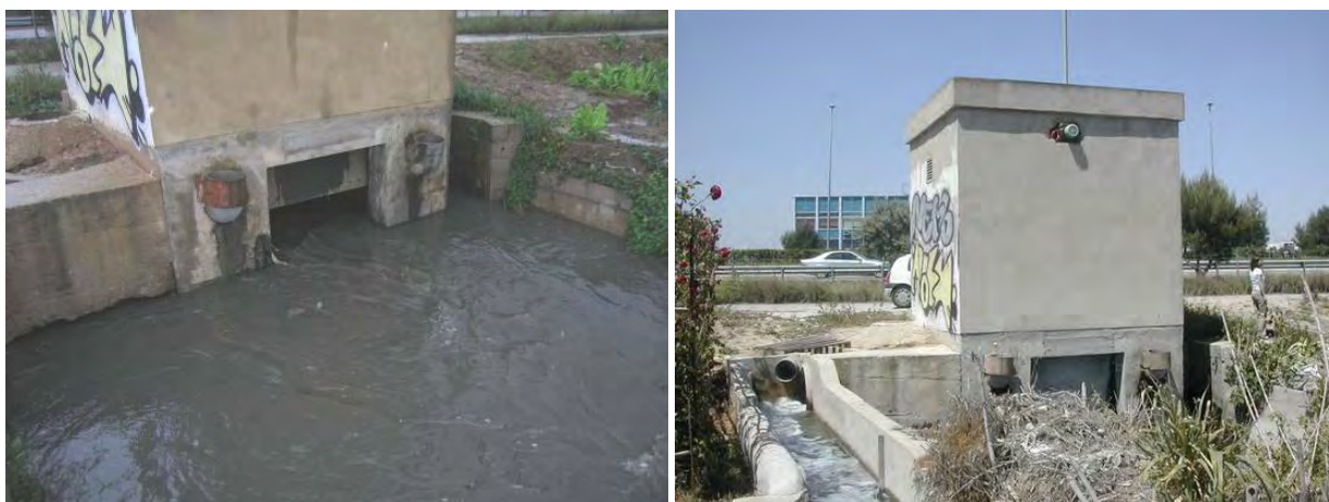
Figura 2-40. Paso de la Rambleta aguas debajo de la V-31 vista desde la caseta de Les Almenares un día de lluvia. Restablecimiento del riego de Favara tras la tormenta.
