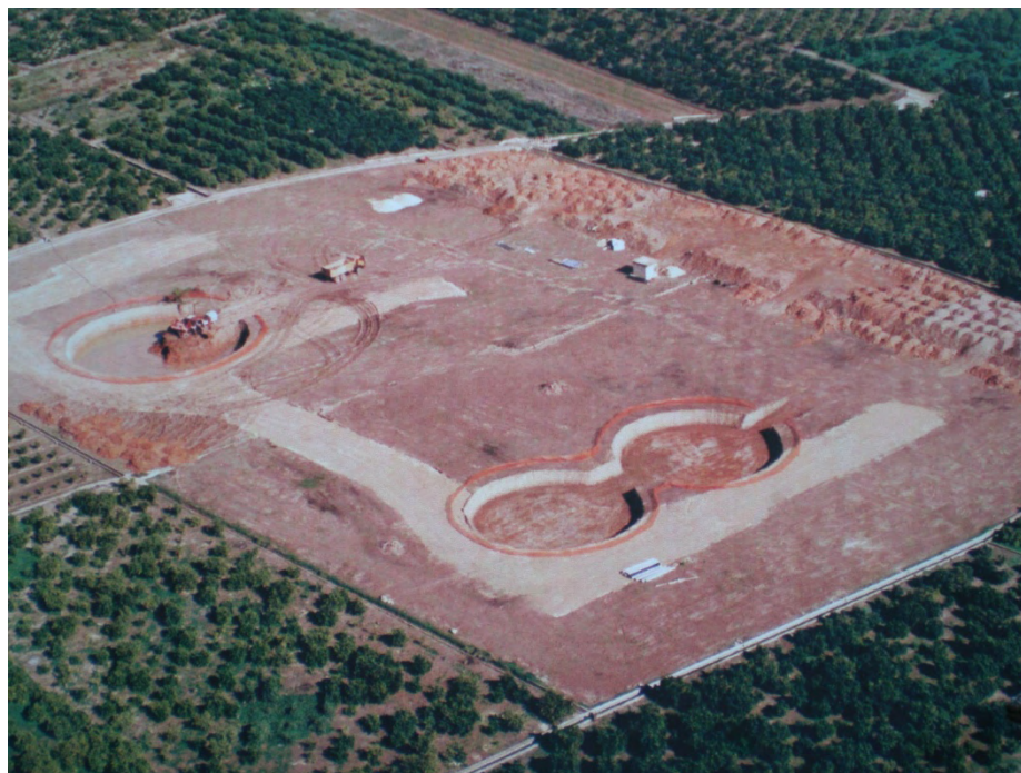
Figura 2-11. Obras de la EDAR de Algemés – Albalat, noviembre de 1998. Fuente: Castón (2000)
