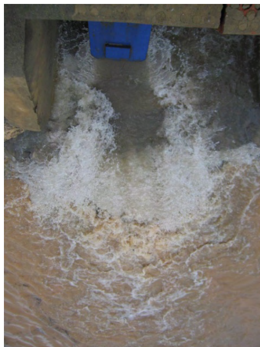
Figura 2-65. Aliviadero de la estación de bombeo de Beniparrell al barranco
