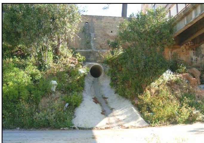
Figura 2-36. Aliviadero al barranco del Poyo en Picanya
