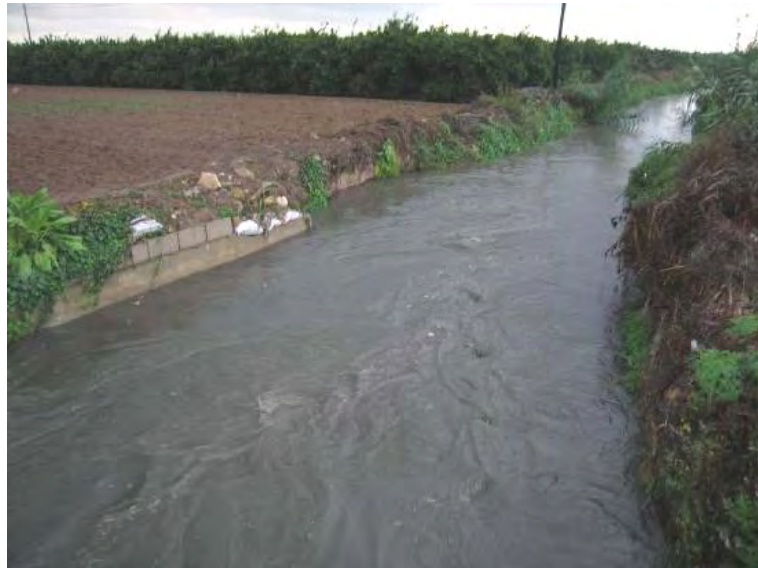
Figura 2-43. Acequia Rambleta aguas abajo de la V-31. Vista un día de lluvia.
