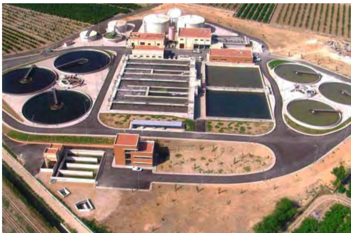
Figura 2-74. Imagen aérea de la EDAR de Albufera Sur en mayo de 2005, fecha de su puesta en servicio
