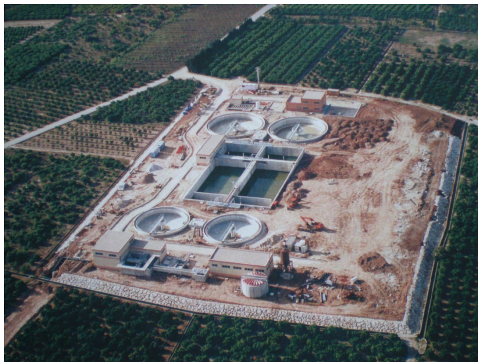
Figura 2-77. Obras de la EDAR de Algemesí – Albalat, mayo de 2000. Fuente: Castón (2000)
