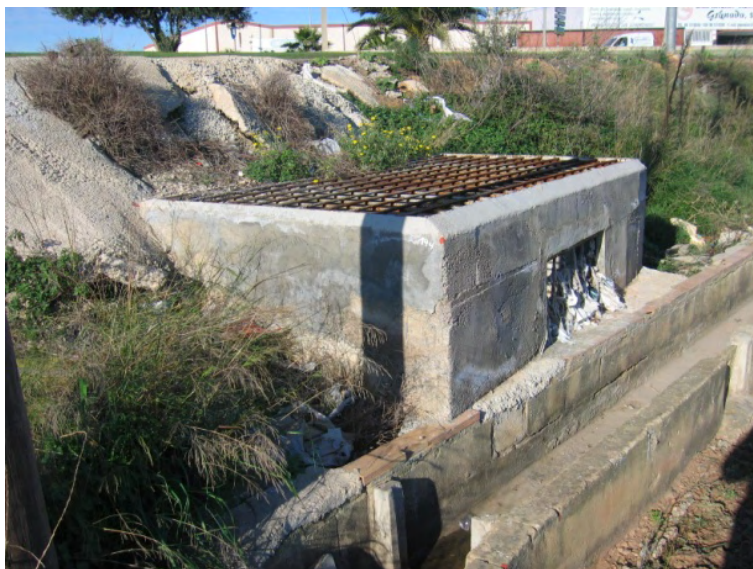
Figura 2-54. Aliviadero de Silla Norte
