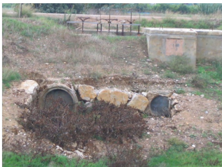
Figura 2-66. Aliviadero al Barranco del Poyo
