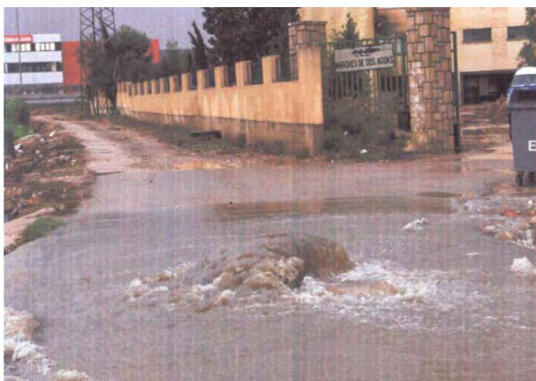
Figura 2-68. Desbordamiento del Colector Oeste en Massanassa
