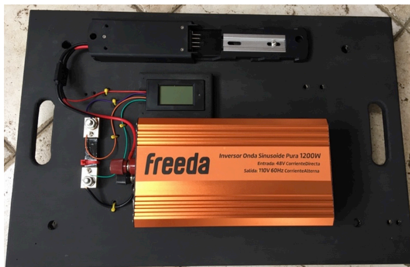
Figura 19 Descargador de baterías
