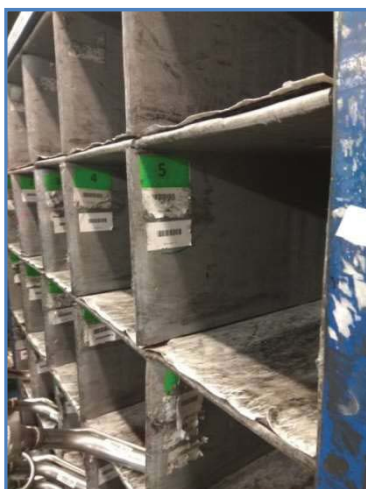
Imagen 19. Defectos observados en uno de los carros.
