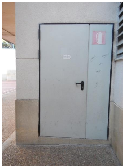
FIGURA 51. ACCESO SUR A SALA DE CALDERAS PARA CALEFACCIÓN
