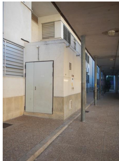
FIGURA 52. ACCESO NORTE A SALA CALDERAS PARA CALEFACCIÓN
