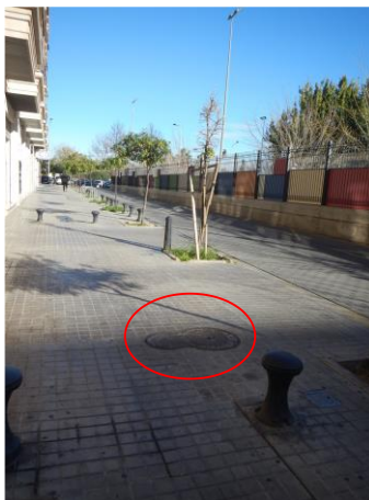
FIGURA 78. VISTA DEL HIDRANTE SITUADO AL OESTE DE LA PARCELA DEL CENTRO
