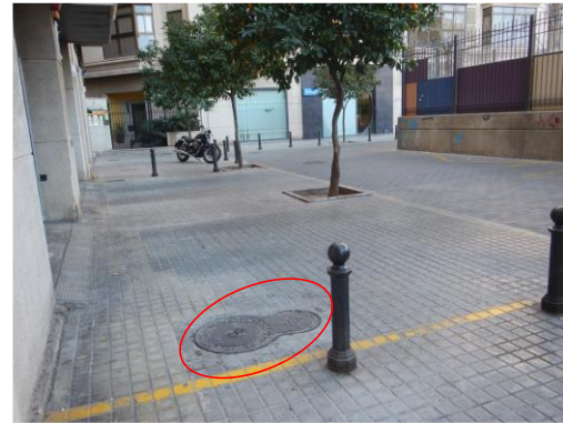
FIGURA 12. VISTA DEL HIDRANTE SITUADO AL SUR DE LA PARCELA DEL CENTRO
