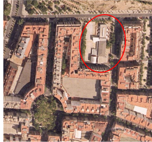
FIGURA 19. VISTA AÉREA DEL AÑO 2000
