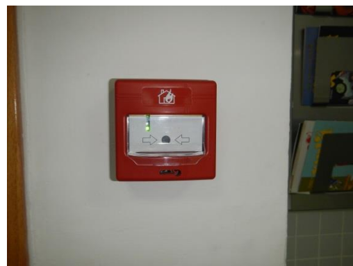
FIGURA 23. PULSADOR DE ALARMA ACCIONADO MEDIANTE LLAVE DE LA BIBLIOTECA
