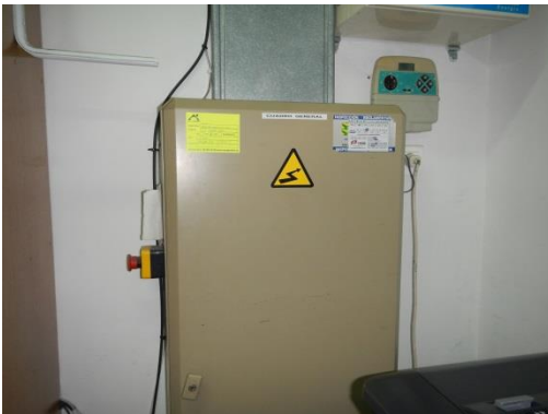
FIGURA 36. CGBT Y BOTÓN PARADA EMERGENCIA
