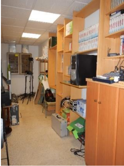
ALMACEN DE USOS MÚLTIPLES CON CUADRO SECUNDARIO DE PLANTA BAJA
