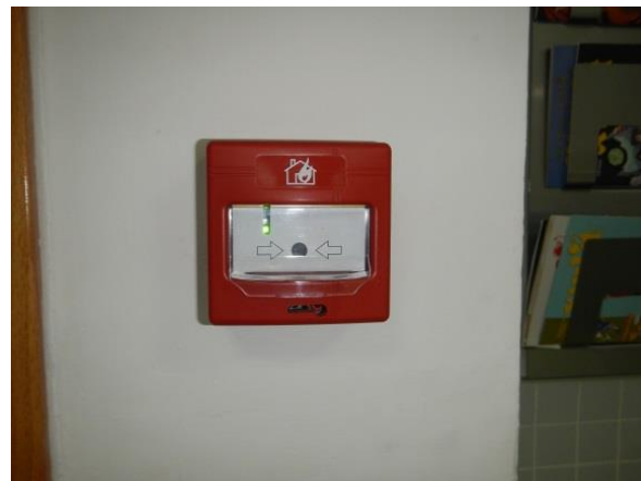
FIGURA 71. PULSADOR MANUAL CON ACCIONAMIENTO MEDIANTE LLAVE
