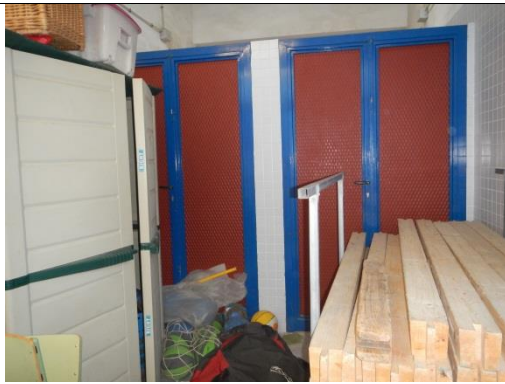
FIGURA 11. SALIDAS EN PASILLO DE EDIFICIO SECUNDARIO, DR.S. 9 Y SR.S. 10 ACTUALMETE BLOQUEADAS
