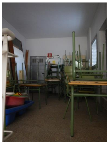
FIGURA 5. VISTA DEL ALTILLO Y AL FONDO PUERTA DE ACCESO A LA SALA DE MÁQUINAS DEL ASCENSOR
