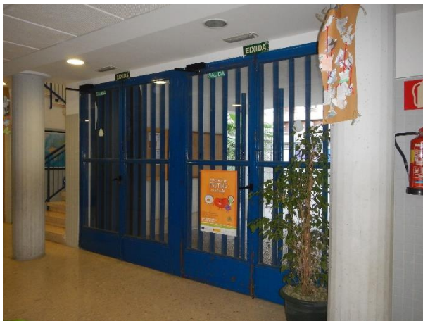
FIGURA 85. ALUMBRADO DE EMERGENCIA EN SALIDA DEL EDIFICIO
