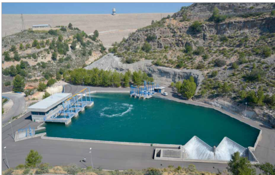
Imagen 17: Estanque de regulación. Libro La presa de Tous.
