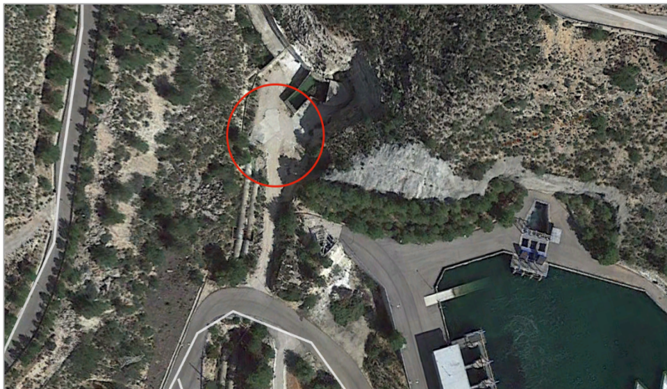
Imagen 28: Emplazamiento de la central en el canal Júcar-Turia. Google Earth.
