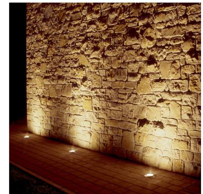
Para la iluminación exterior del edificios se utilizan focos lineales de luz cálida que se colocan a lo largo de los distintos muros. Son piezas que van empotradas en el suelo y que es posible transito peatonal sobre ellas. Están enfocados hacia el muro y con esto se consigue que se proyecte la luz sobre la pared rugosa y se creen sombras.
